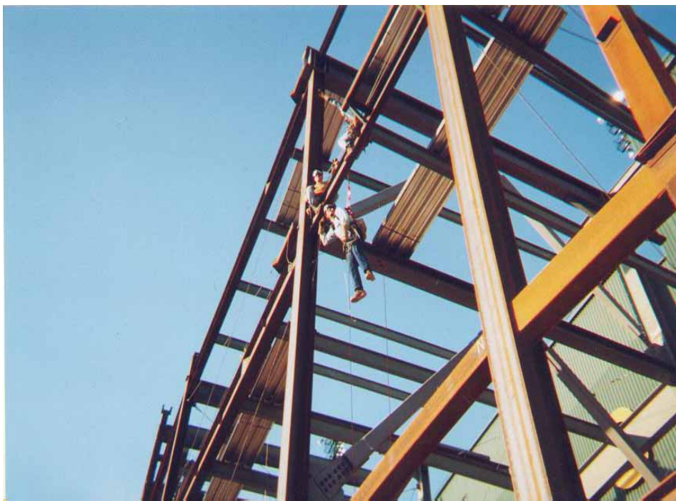
شکل ۲-۱- جلوگیری از سقوط فرد با استفاده از کمربند ایمنی
