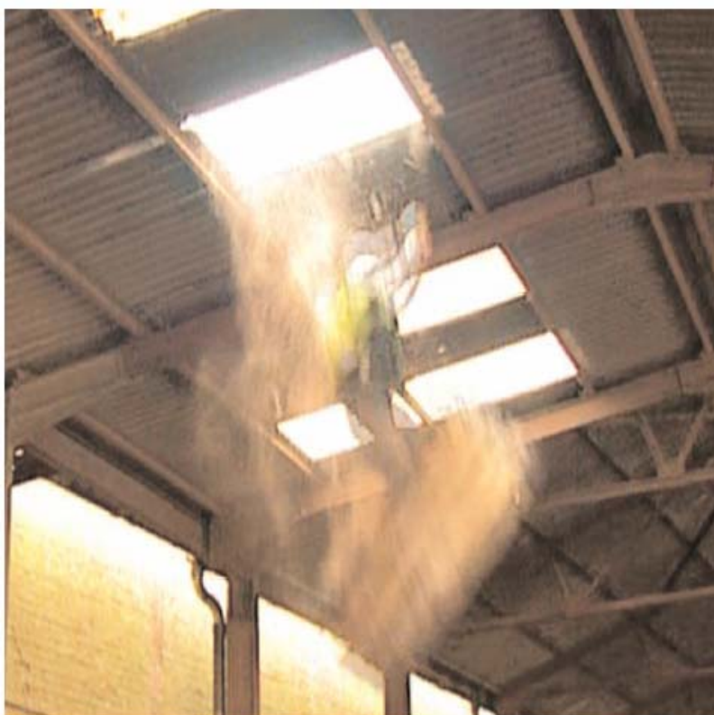
شکل ۳-۳- افتادن فرد از روی سقف‌های سست و شکننده
