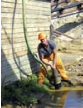
شکل ۲-۳۲- کاربرد پمپ کفکش
