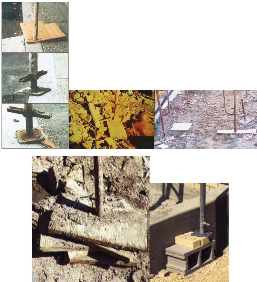
شکل ۲۰- انواع روشهای غیر ایمن استقرار داربست
