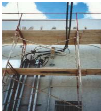
شکل ۱۴- نمونه هایی از نصب غیر ایمن داربست در کنار خطوط برق
