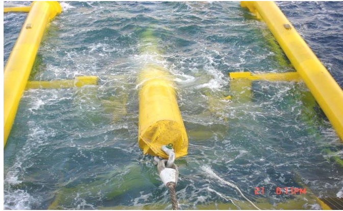
شکل ۸: عملیات رهاسازی خط لوله در بستر دریا
