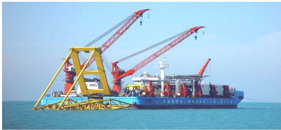
شکل ۵: بارج PLB132 در حال لوله گذاری در خلیج فارس
