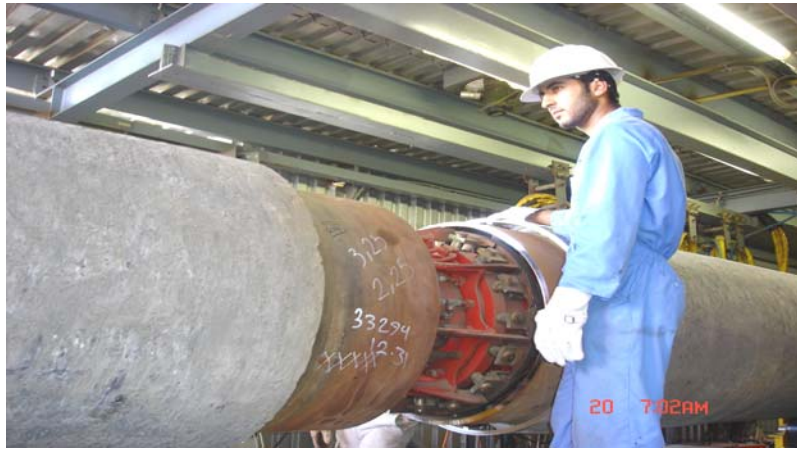
شکل ۶: Line up کردن دو لوله در ایستگاه اول_بارج PLB132
