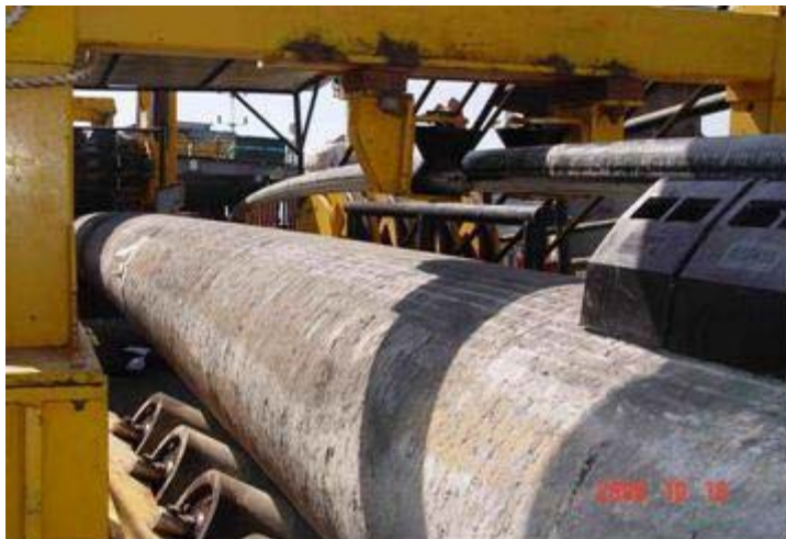
شکل ۱۱- رسیدن دو خط لوله به یکدیگر
