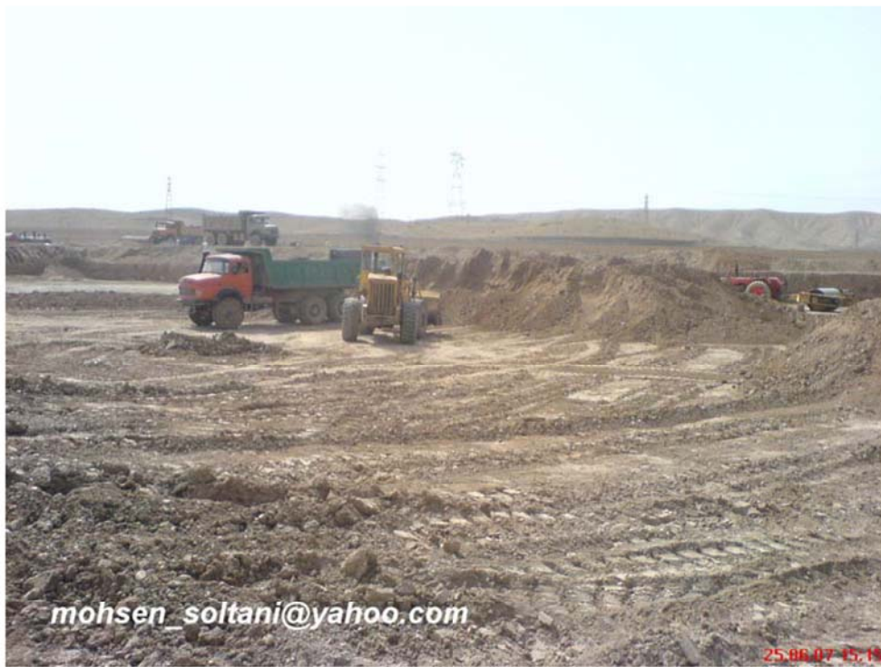
شکل ۵- عملیات خاکبرداری زیر مخزن
