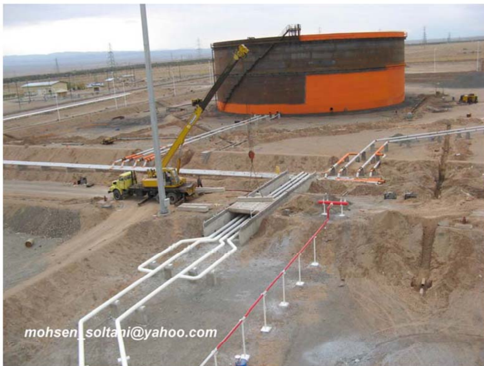
شکل ۳۳_ قرار دادن Slab ها بر روی پل
