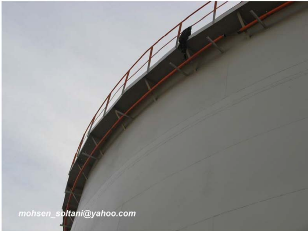
شکل ۶۱- لوله های Watercooling بر روی بدنه مخزن
