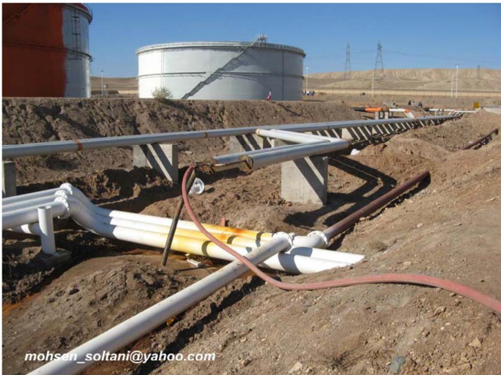
شکل ۷۰- آبیگری خط لوله سوخت جهت هیدروتست
