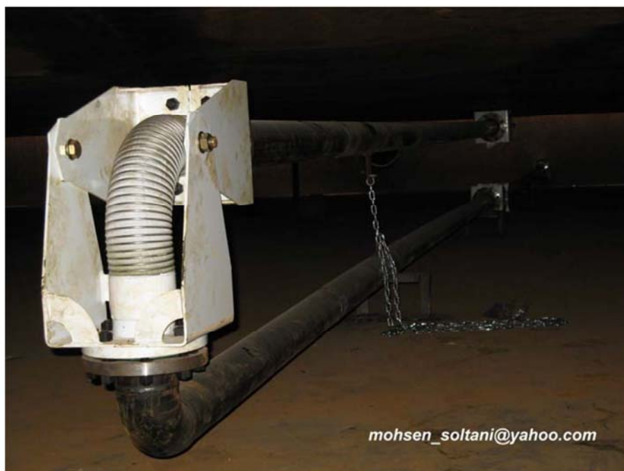
شکل ۳۷- لوله Roof drain
