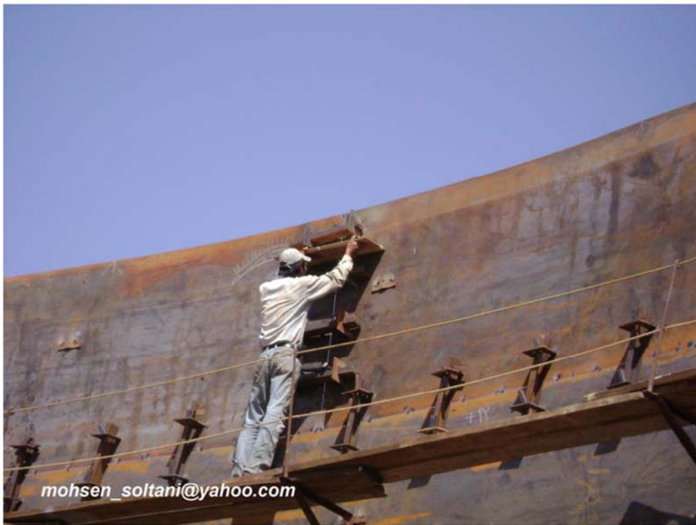
شکل ۳۱- تست Peaking
