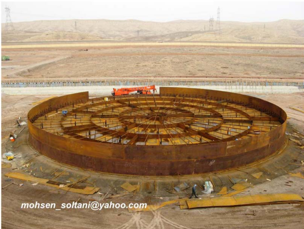
شکل ۱۴- مونتاژ Rim ، Truss و Compartment
