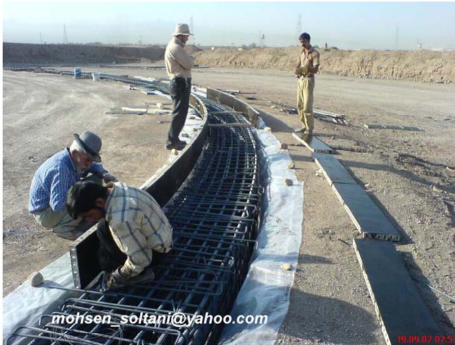
شکل ۱۲- آرماتوربندی رینگ وال
