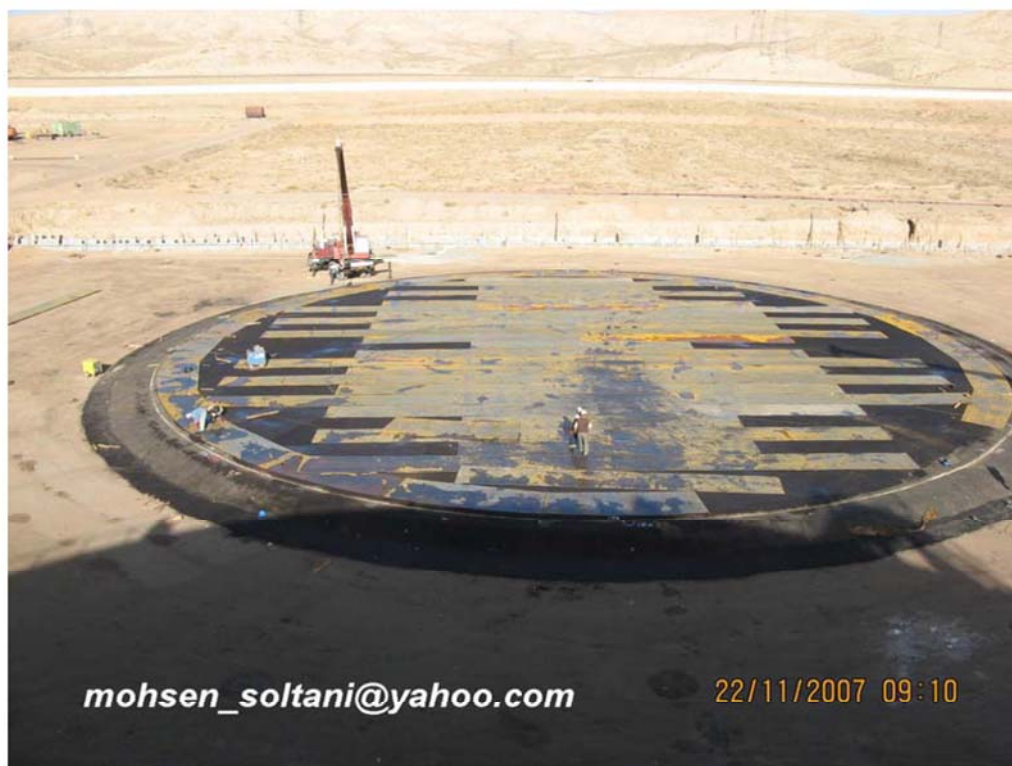
شکل ۳_ عملیات چیدمان ورقهای کف
