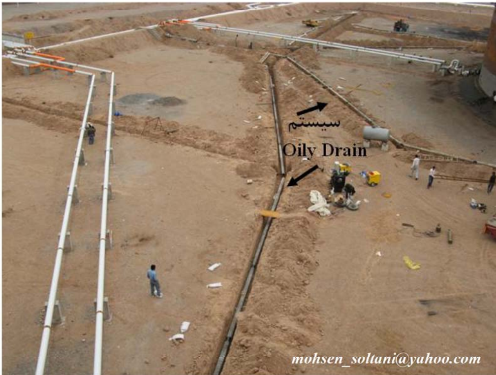
شکل ۶۶- خط لوله سیستم OilyDrain
