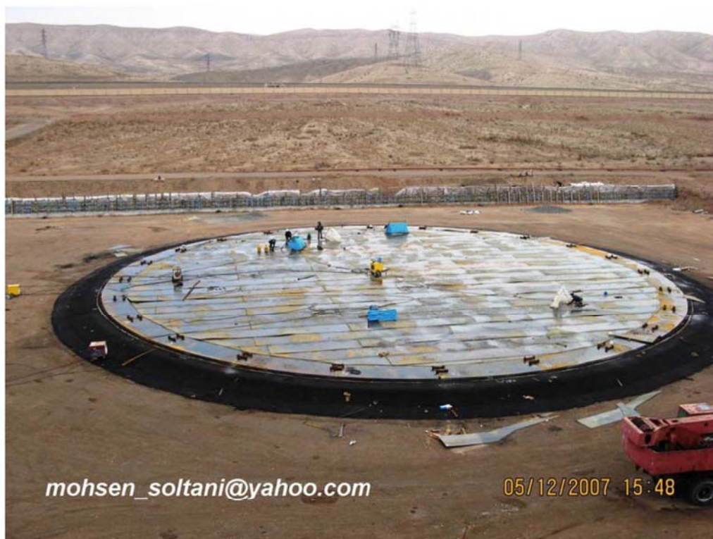
شکل ۴_ تکمیل چیدمان ورقهای کف
