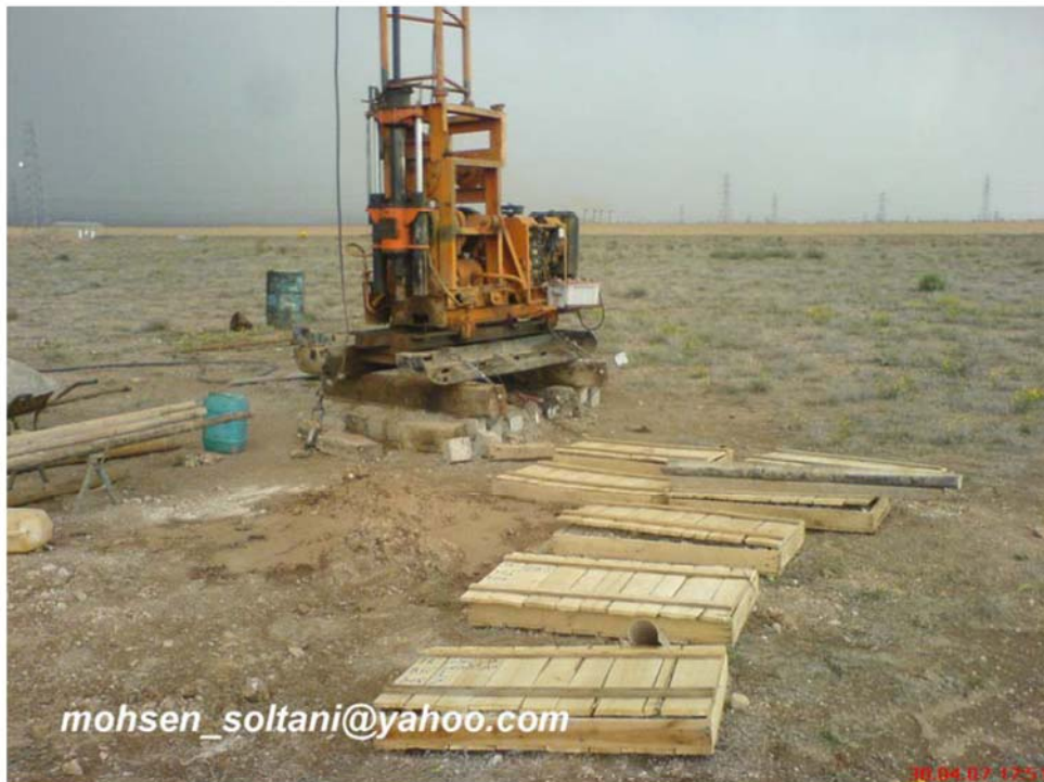
شکل ۱- عملیات گمانه زنی اولیه
