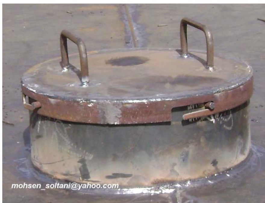
شکل ۳۵- Pontoon manhol
