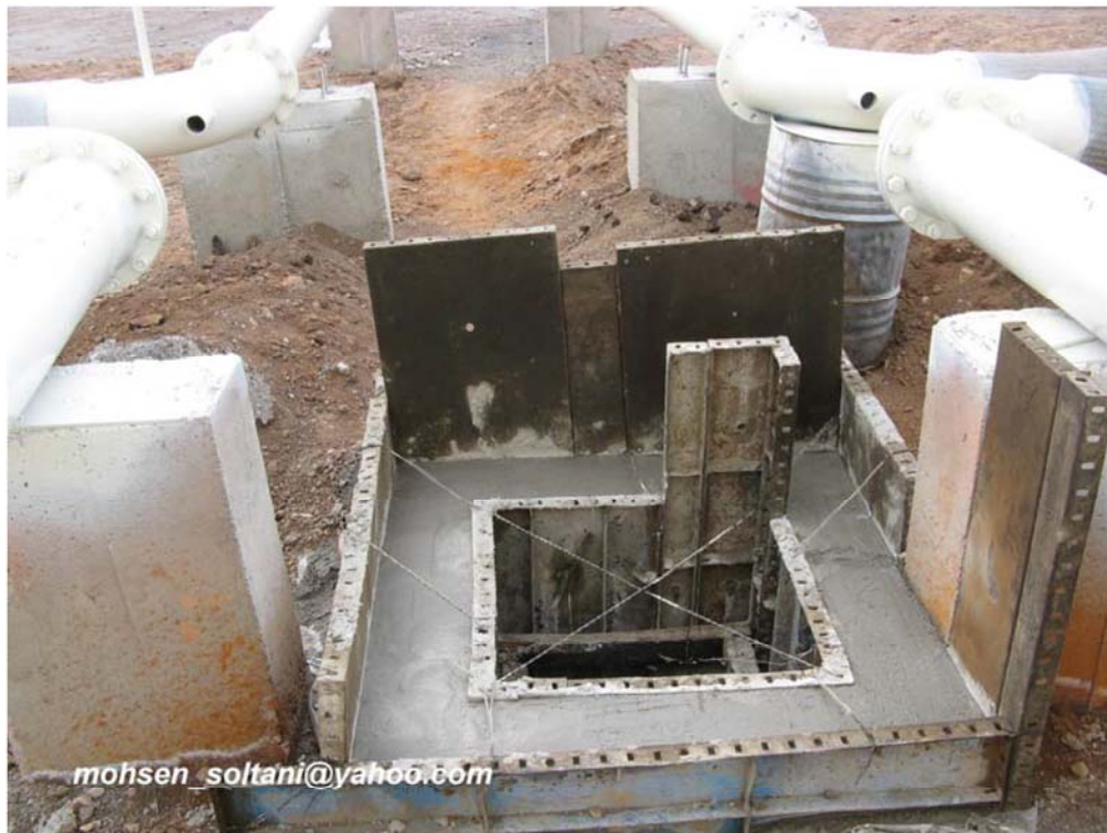
شکل ۶۴- ساخت Pit خط لوله OilyDrain
