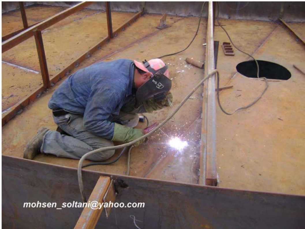
شکل ۱۳- عملیات جوشکاری lower deck
