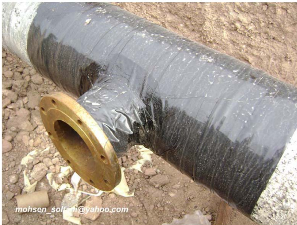
شکل ۶۷- عایق کاری لوله های خط آتش نشانی
