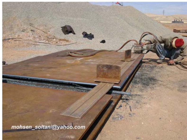
شکل ۹ - پخ زدن لبه ورقها
