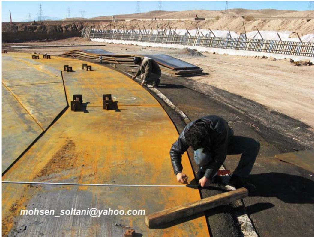
شکل ۱- ورقهای Annular
