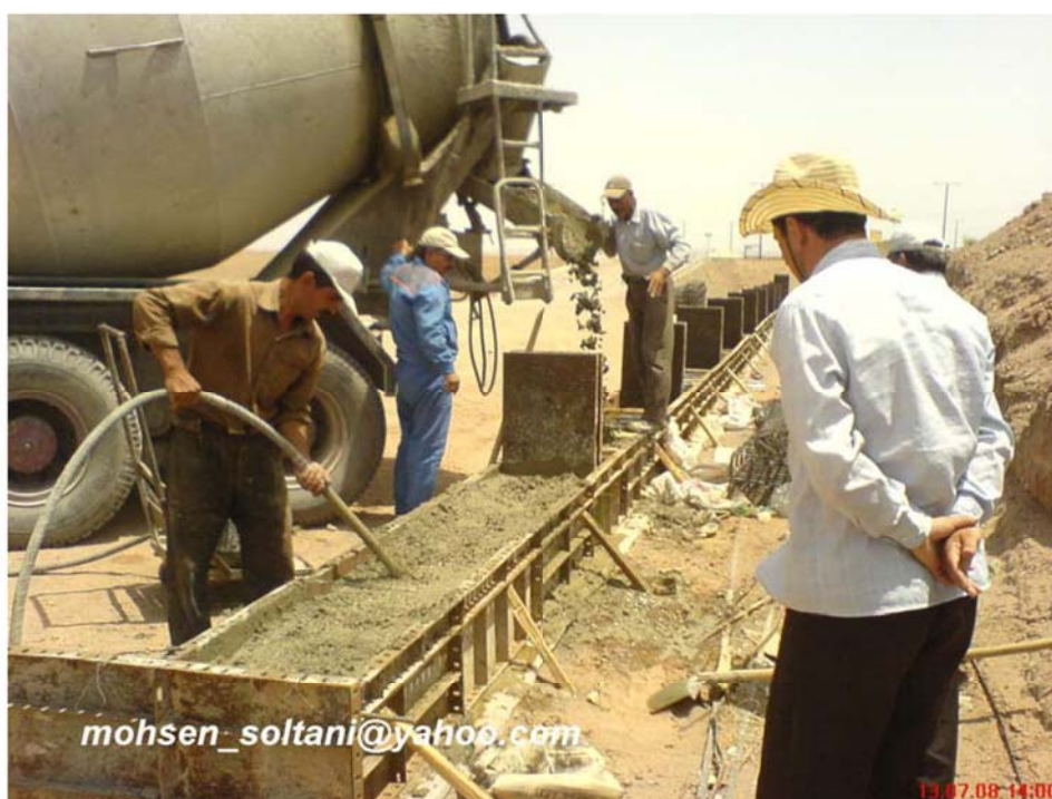
شکل ۳۲_ بتن ریزی slab
