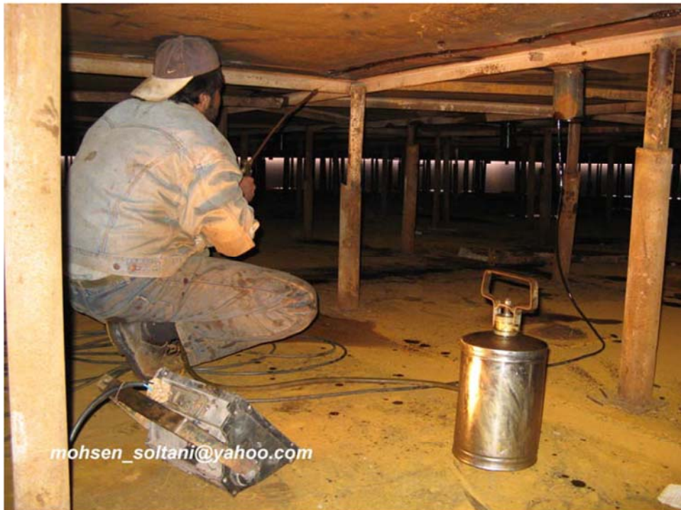
شکل ۲۹- عملیات تست گازوییل
