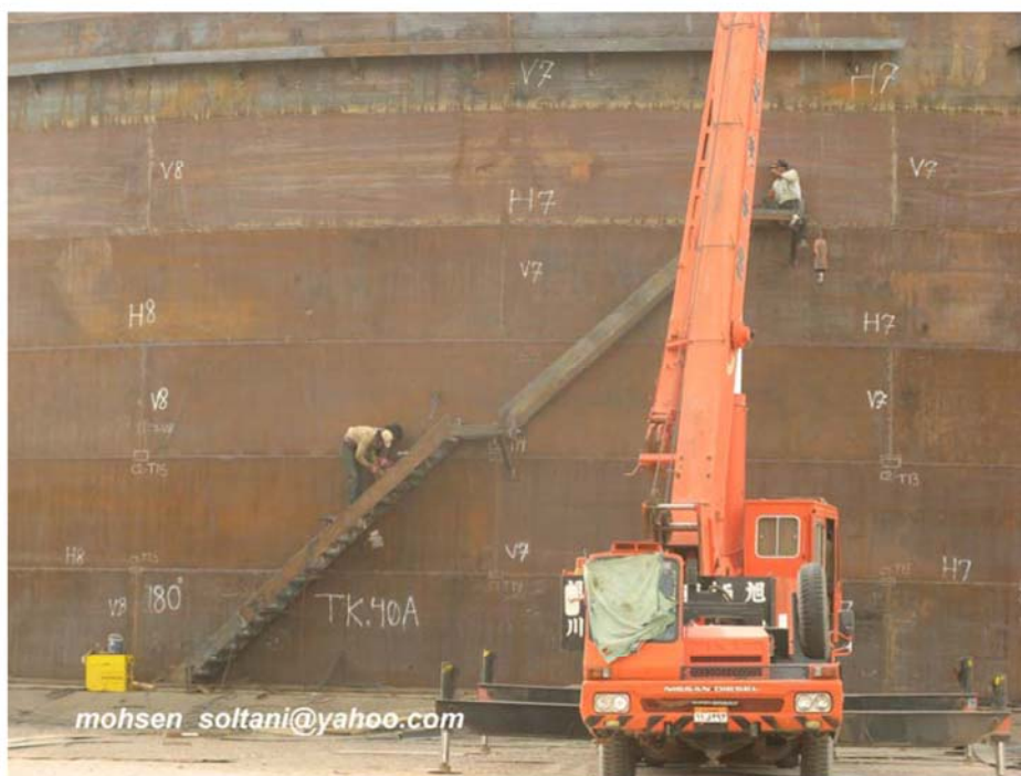
شکل ۴۹ - نصب پله های بیرونی بدنه مخزن
