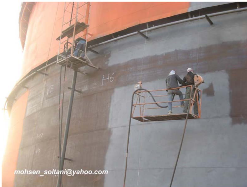
شکل ۵۴- سندبلاست بدنه مخزن
