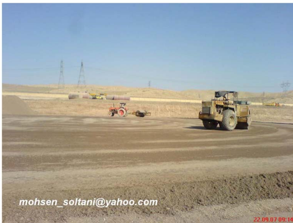
شکل ۷- عملیات کوبش خاکریزی زیر مخزن
