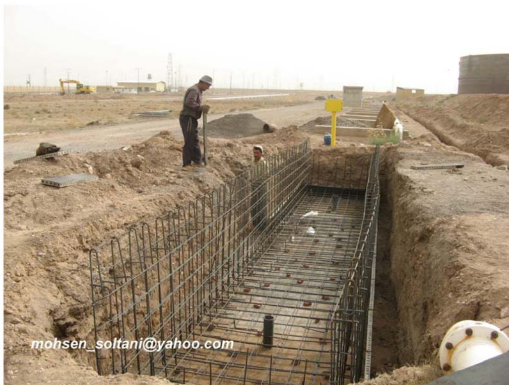
شکل ۳۰_ آرماتور بندی پل
