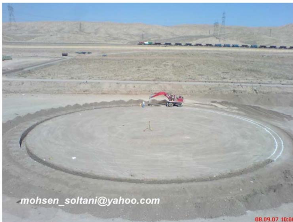
شکل ۹- عملیات حفر کانال رینگ
