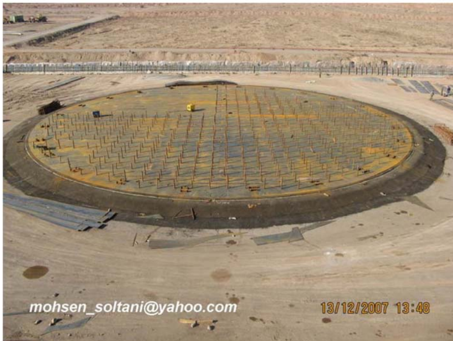
شکل ۷- نصب میز موقت
