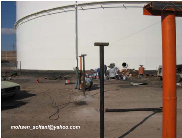
شکل ۶۲- نصب ساپورت های خط لوله سیستم فوم
