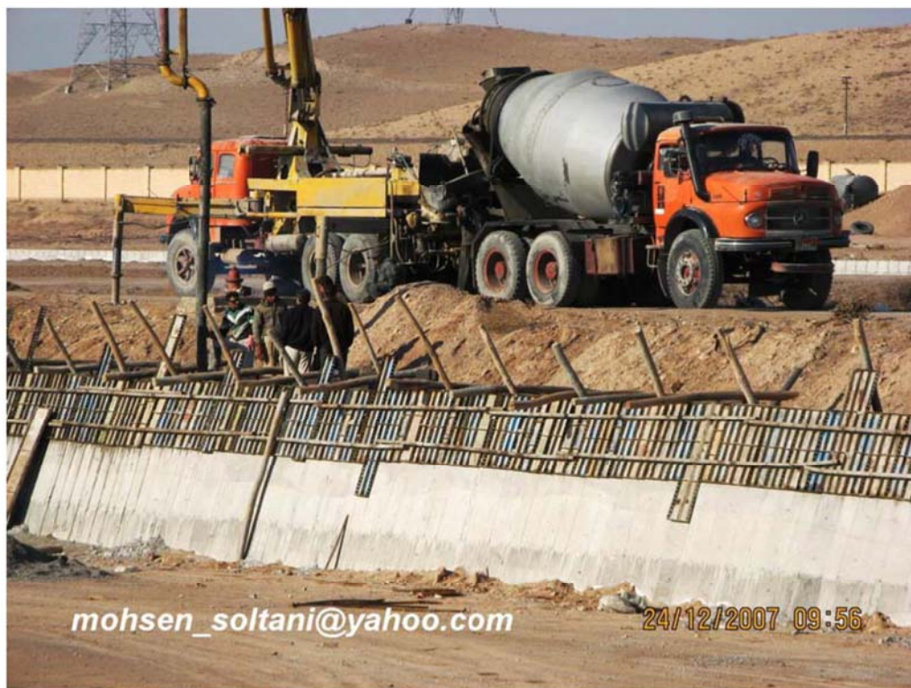
شکل ۲۱_ عملیات بتن ریزی دیوار حائل
