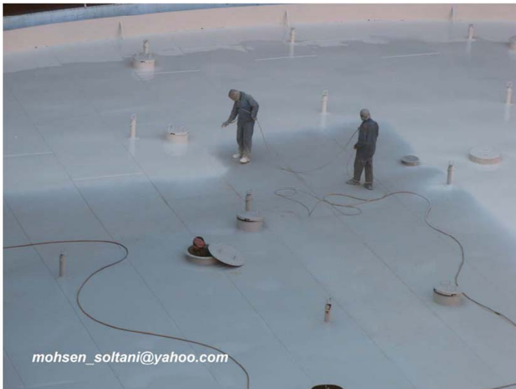
شکل ۵۶- عملیات رنگ آمیزی لایه نهایی رنگ سقف شناور
