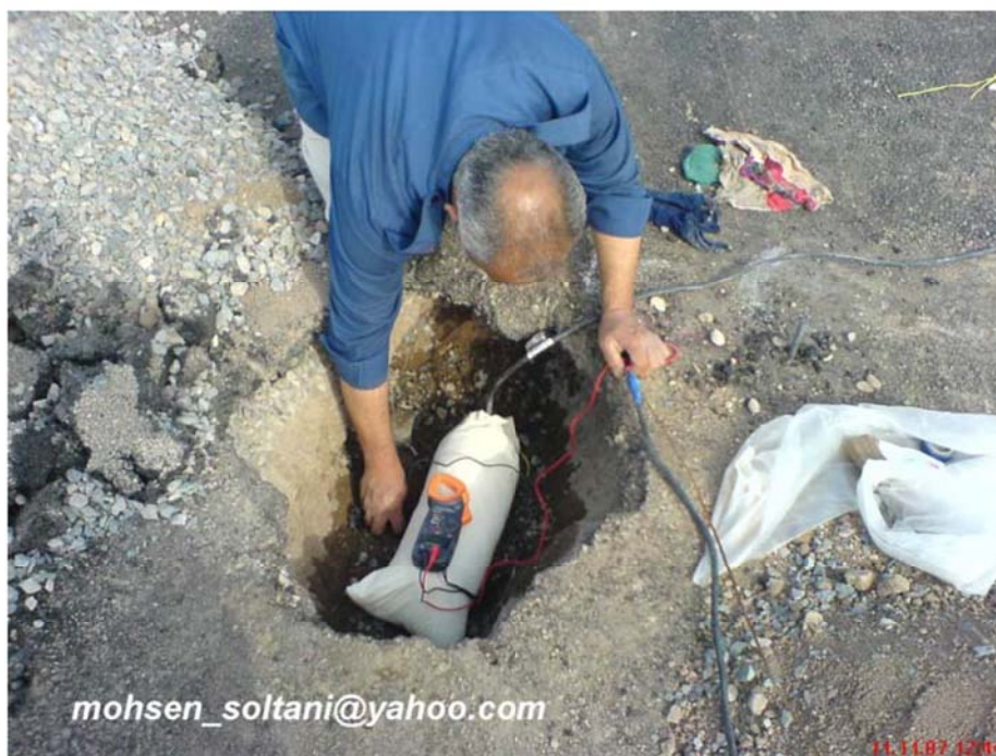
شکل ۲۷_ اجرای سیستم حفاظت کاتدیک ( نصب الکتروود مرجع )
