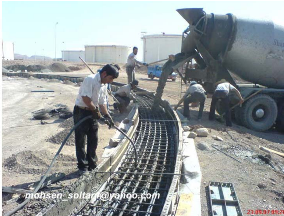
شکل ۱۳- بتن ریزی رینگ وال
