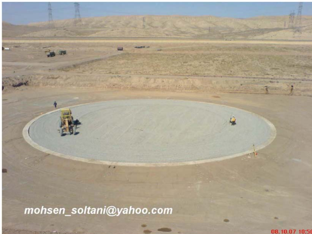
شکل ۱۴- رینگ وال بتنی تکمیل و شن ریزی شده
