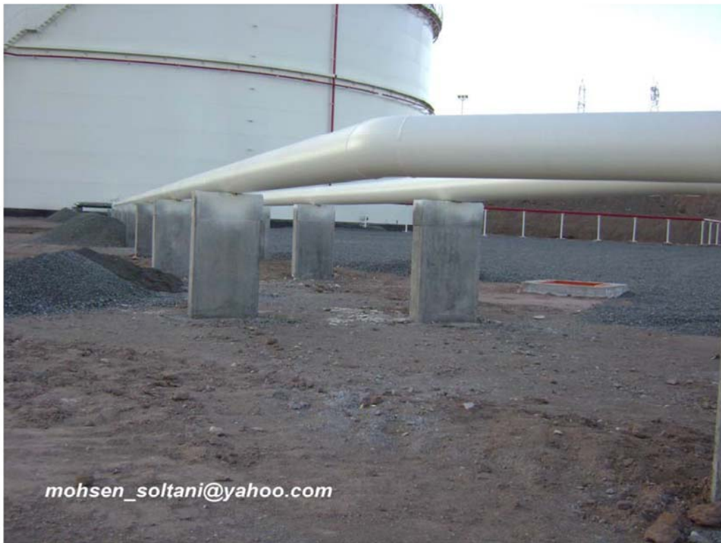
شکل ۳۵- ساپورتهای بتنی زیر لوله فرآورده
