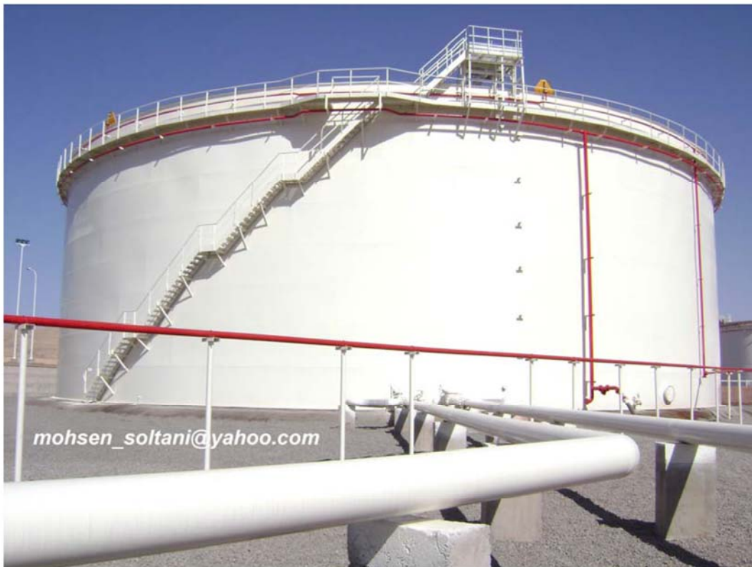
شکل ۵۷- تکمیل رنگ لایه نهایی بدنه مخزن
