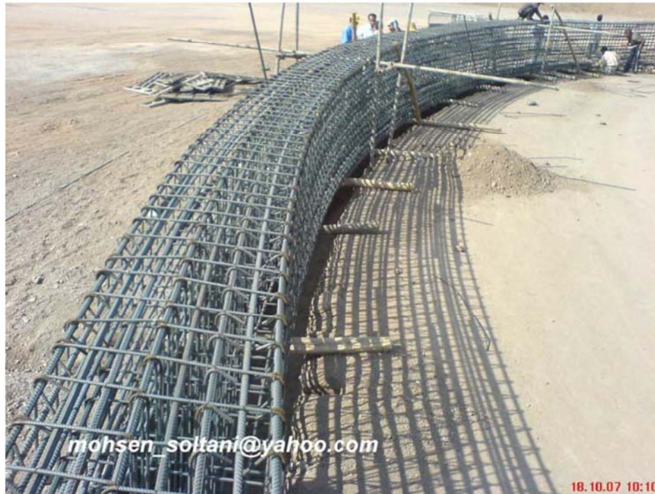
شکل ۱۱_ آماده سازی و ساخت آرماتور رینگ وال
