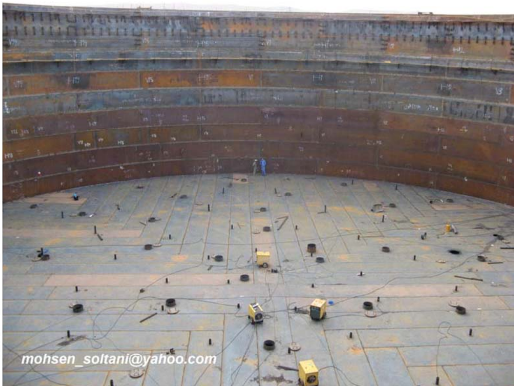
شکل ۳۳- سقف شناور
