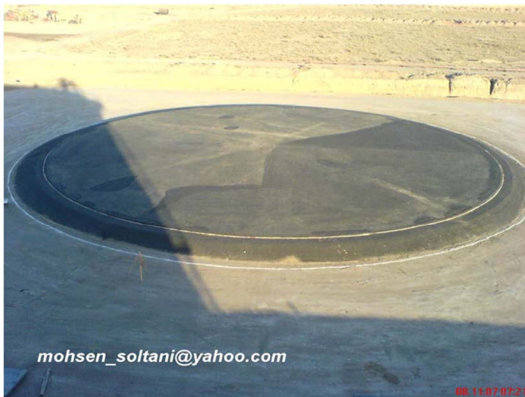
شکل ۱۷- آسفالت زیر مخزن
