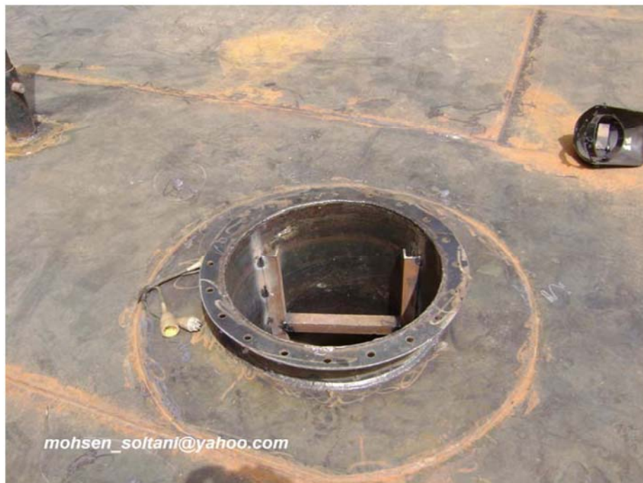
شکل ۳۶- Roof manhole
