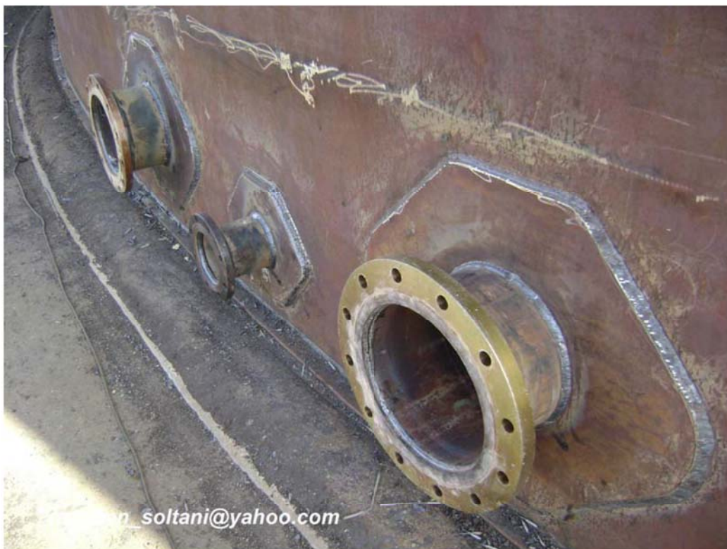
شکل ۵۱- Inlet & Outlet Nozzle
