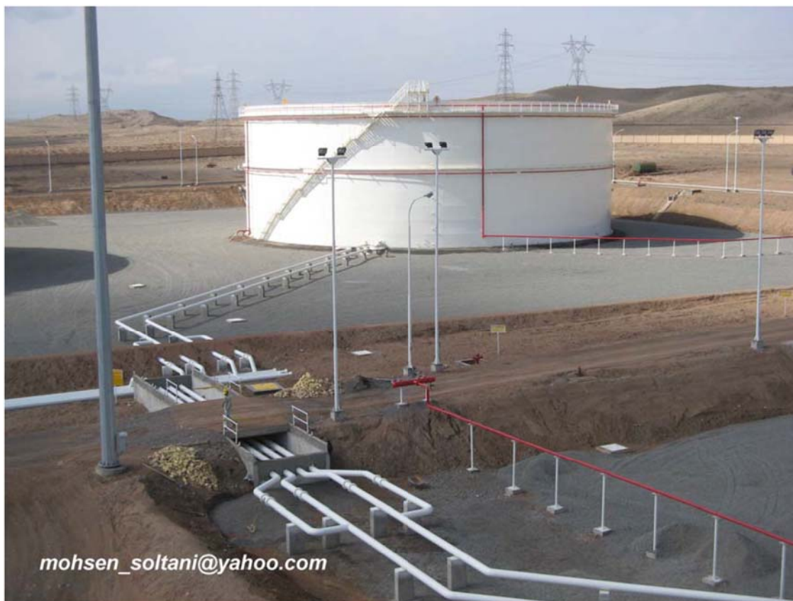
شکل ۷۱_ مخازن تکمیل شده پس از شن ریزی
