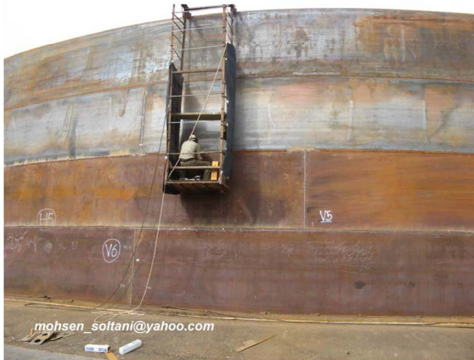
شکل ۲۴- عملیات جوشکاری ورقهای Shell
