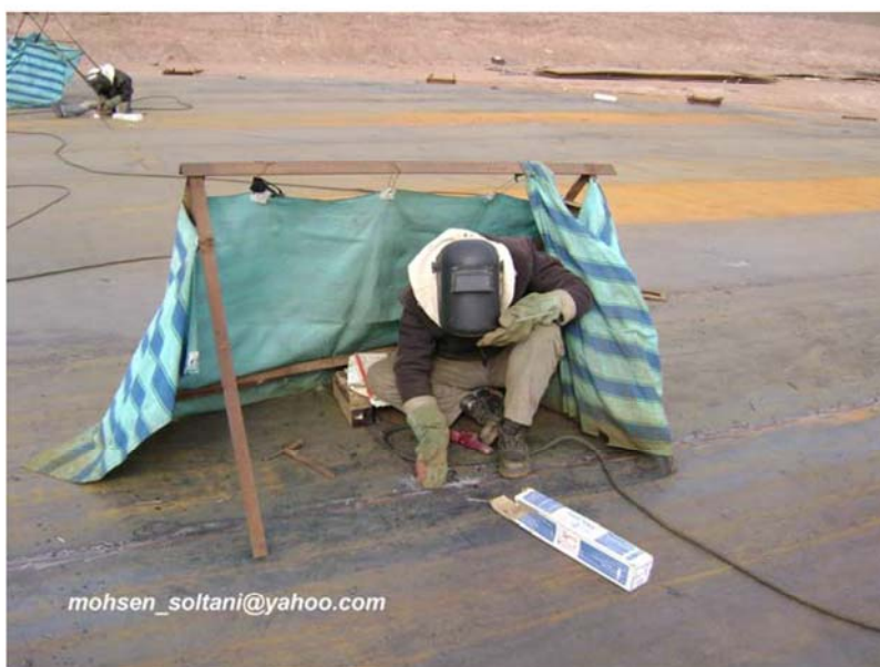
شکل ۵- جوشکاری ورقهای Bottom plate
