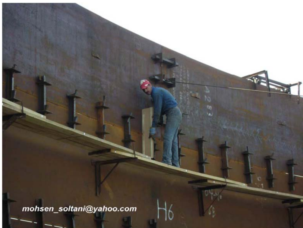
شکل ۳۲- تست Banding
