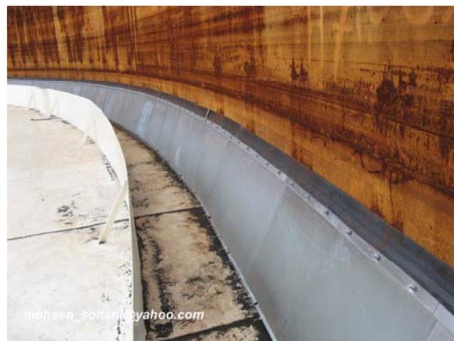
شکل ۴۲- سیستم تکمیل شده Seal سقف شناور
