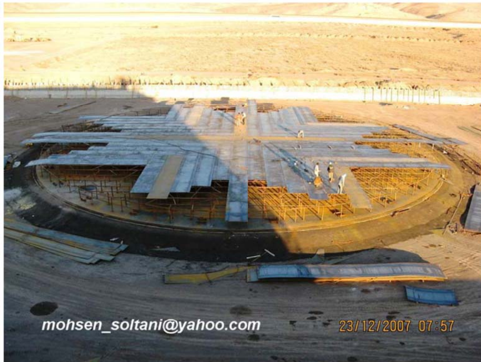
شکل ۱۲- عملیات چیدمان ورقهای Lower Deck
