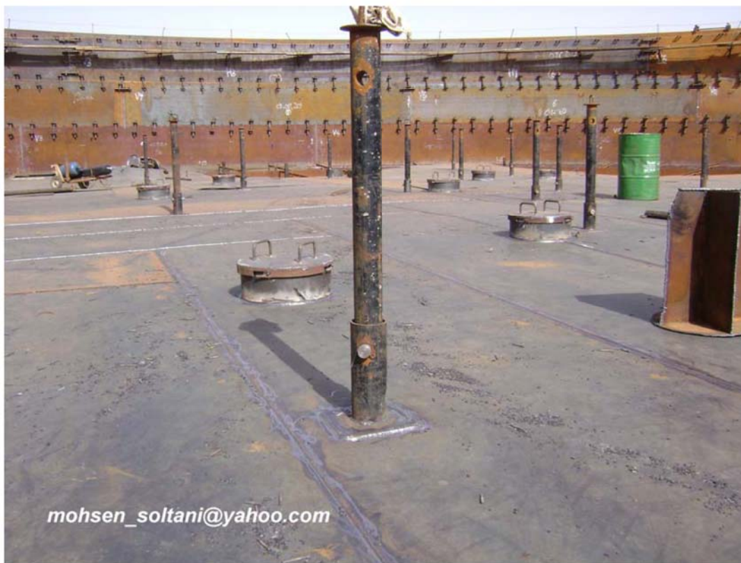
شکل ۳۴- ساپورت‌های سقف شناور
