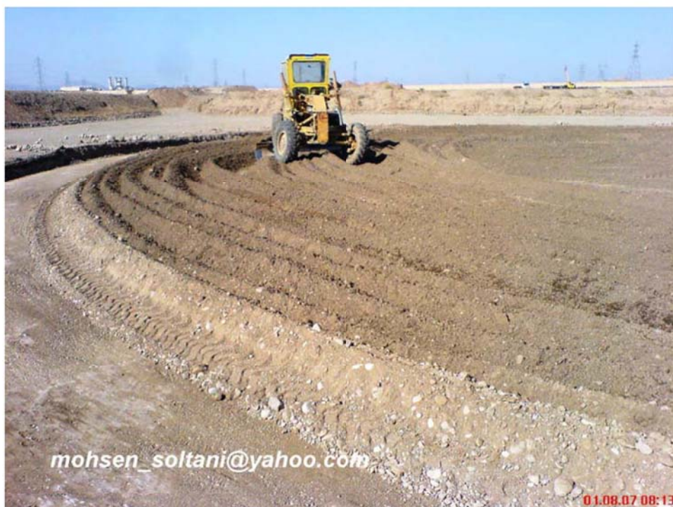
شکل ۶- عملیات خاکریزی زیر مخزن
