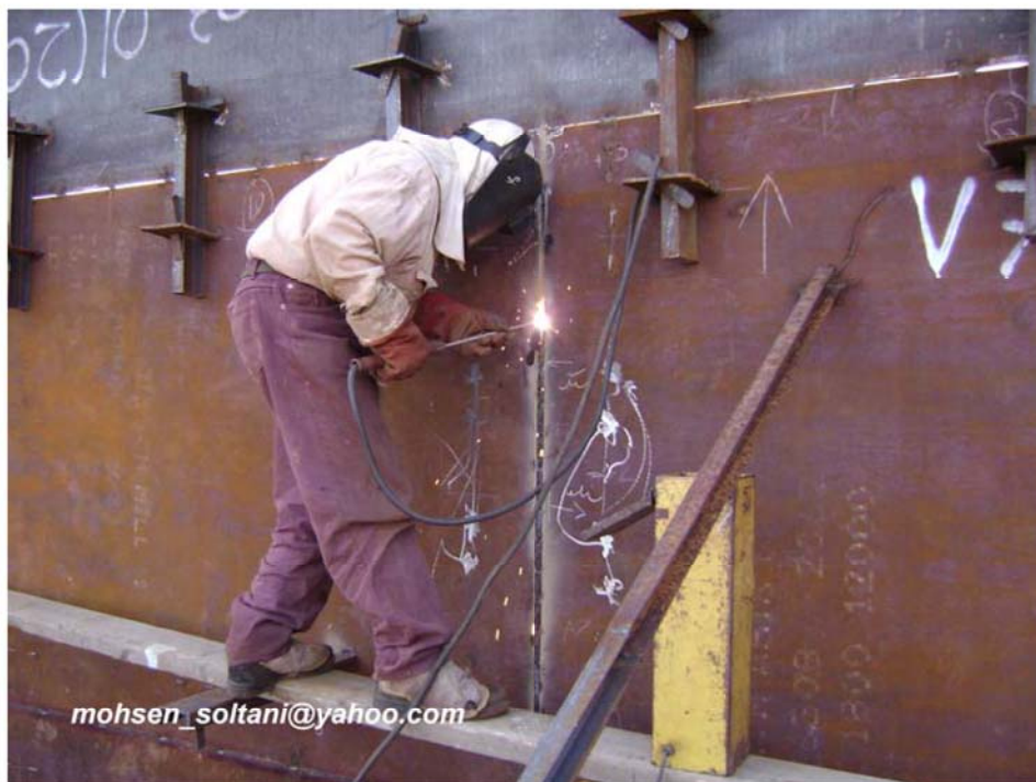
شکل ۲۲- عملیات جوشکاری Backweld
