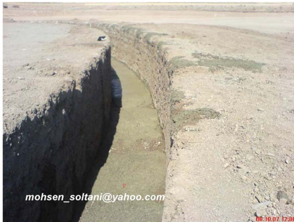
شکل ۱۰- بتن مگر رینگ بتنی
