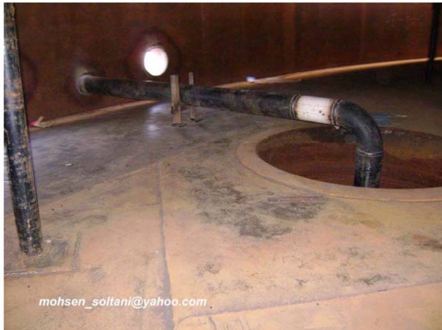
شکل ۴۳- سیستم Draw of sump
