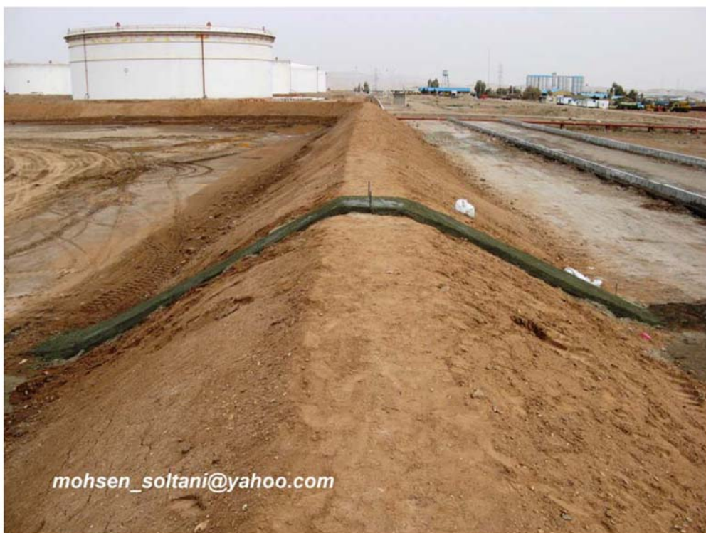
شکل ۲۵_ زیرسازی محل احداث پله های سایت بر روی باند وال
