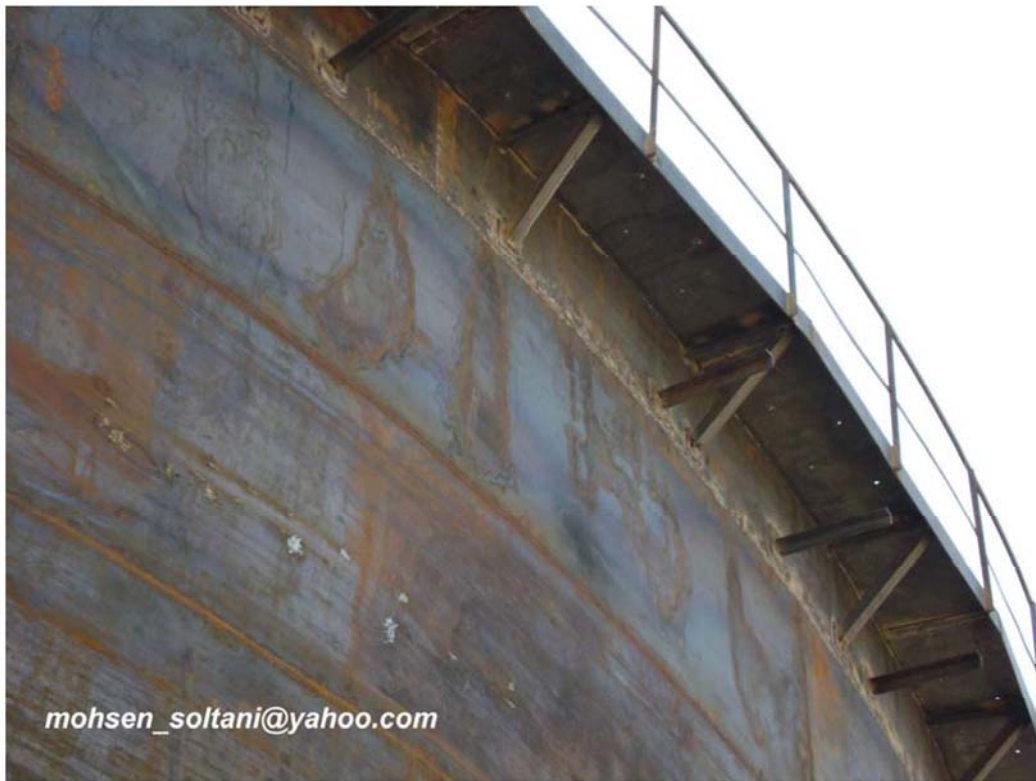
شکل ۴۶- Windgirder نصب و جوش شده
