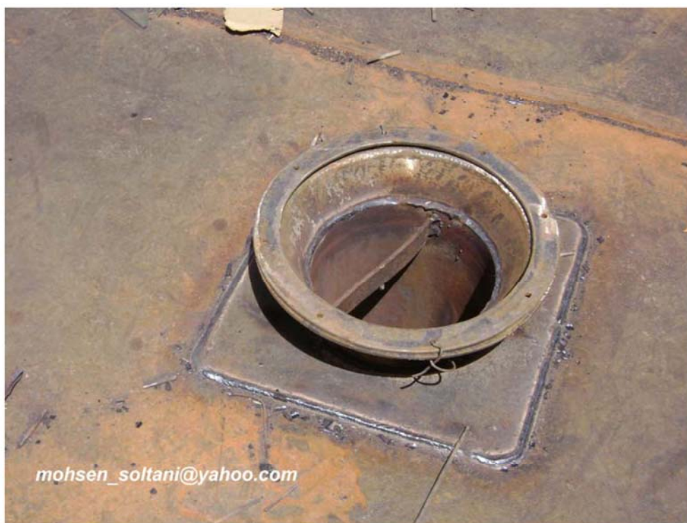
شکل ۴۰- Emergency roof drain
