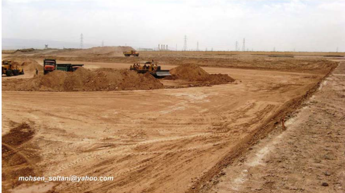
شکل ۴- عملیات خاکبرداری سایت
