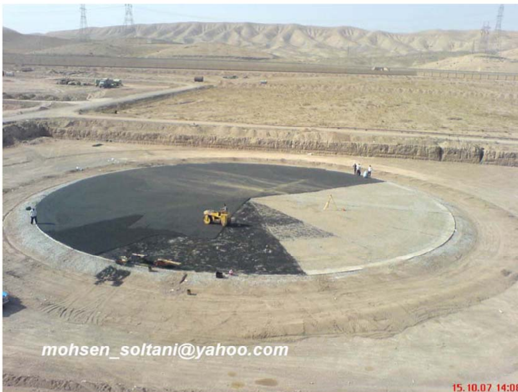
شکل ۱۶- اجرای لایه آسفالت
