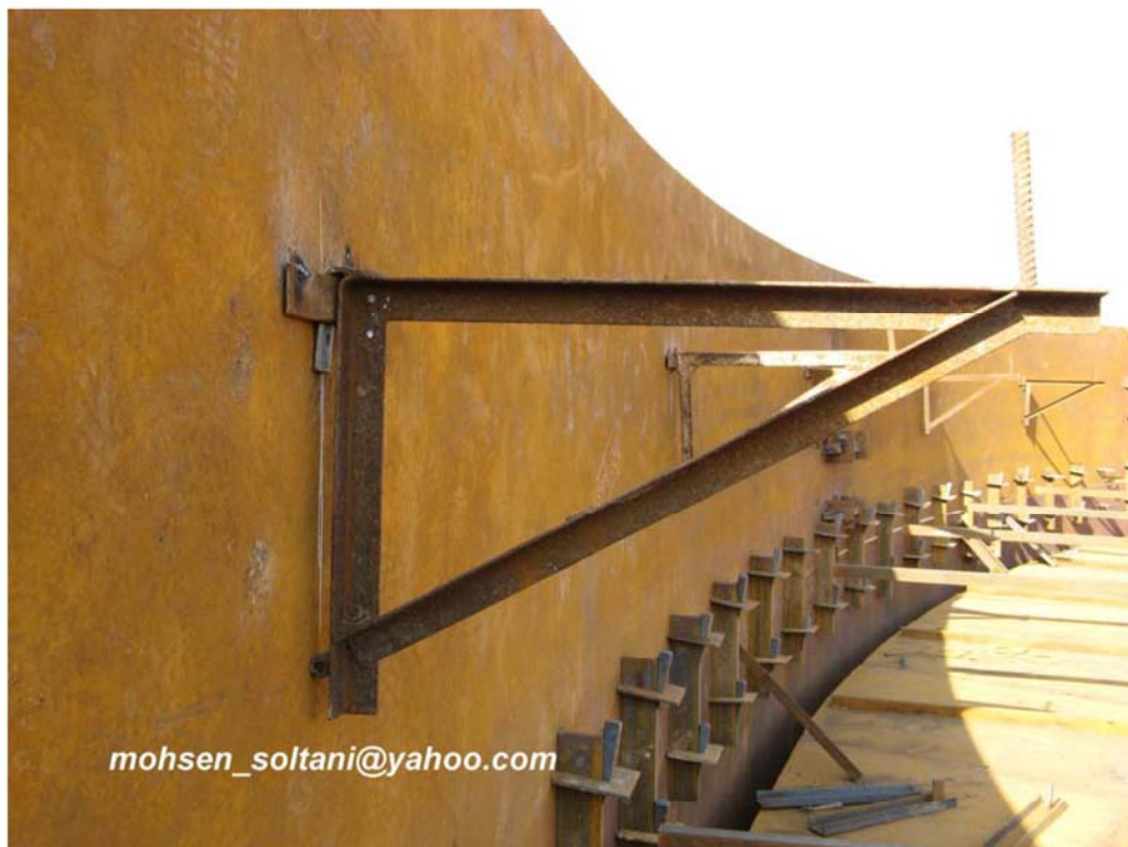
شکل ۱۷_ اتصالات کلنگی جهت نصب تخته داربست درونی مخزن
