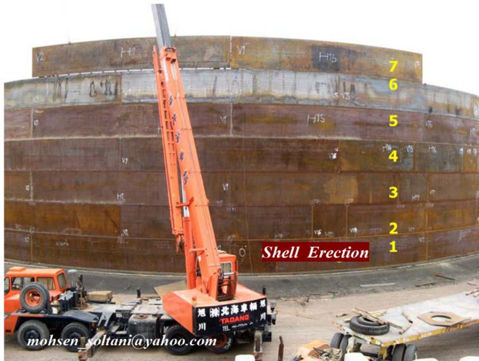
شکل ۲۳- مونتاژ و نصب ورقهای Shell
