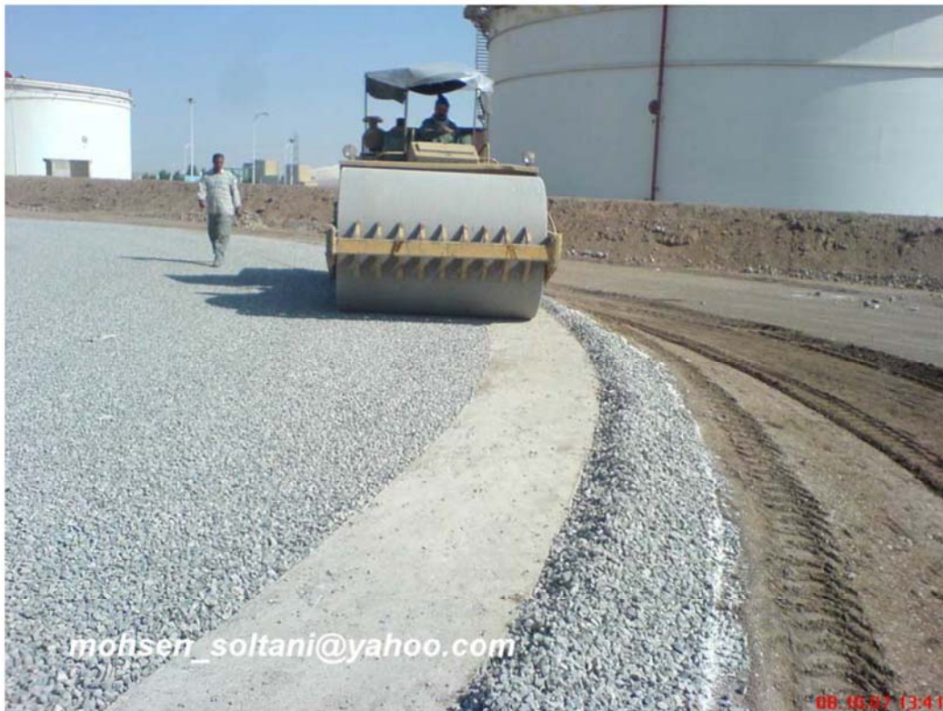
شکل ۱۵- اتوکشی سطح تمام شده شن (لایه فیلتر)
