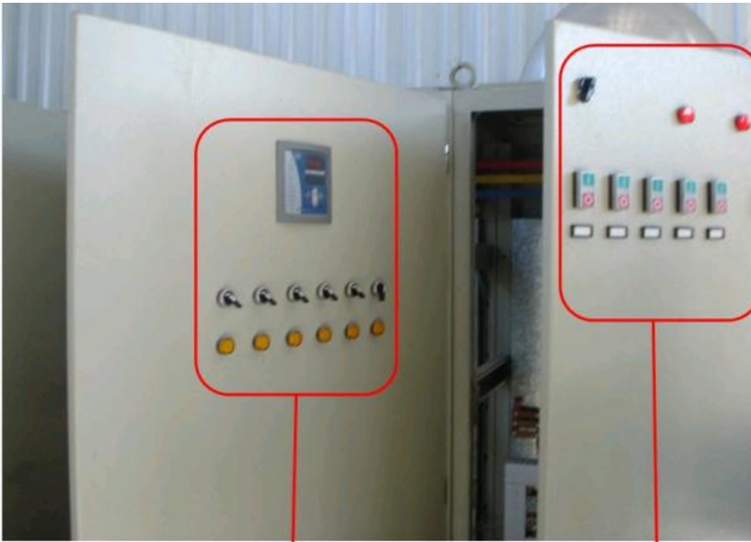
رگولاتور خازنی همراه با کنترل کننده های دستی آن
