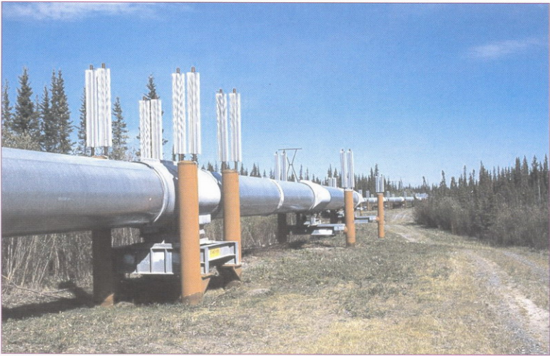
شکل ۹- استفاده از توربین در پمپاژ خطوط لوله
