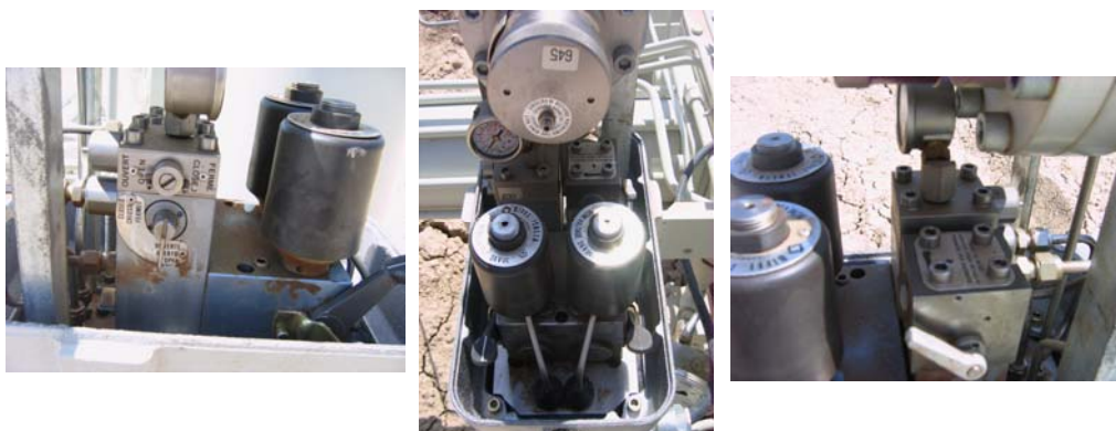
شکل ۴-۵ - نمای مدار فرمان عمل کننده بی‌فی، از راست، روبرو و چپ
