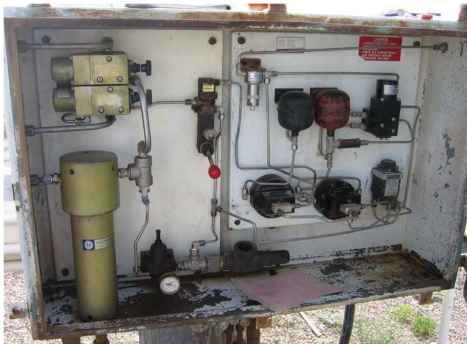
شکل ۴-۴۴ - تصویر واقعی عمل کننده Accu/Tect لدین ایتالیا
