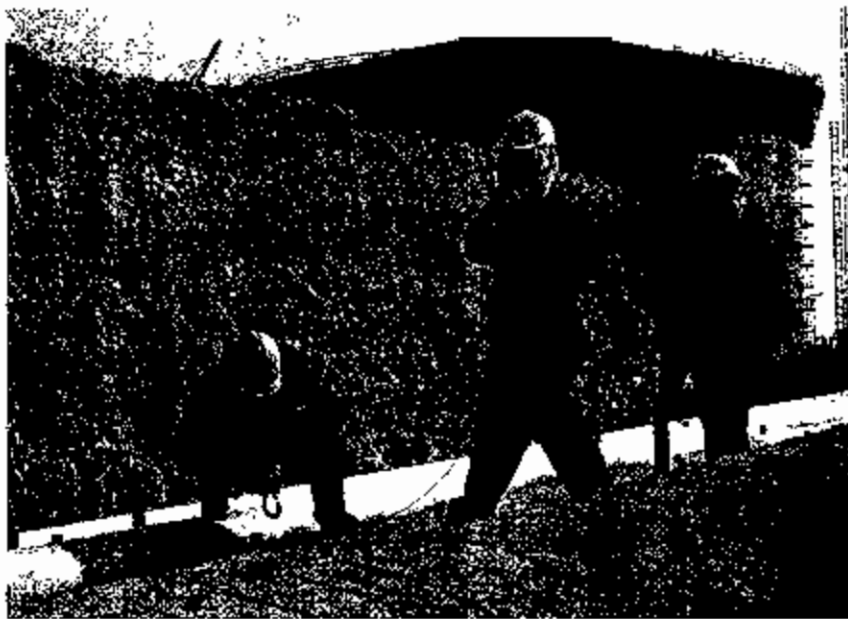
شکل ۲-۳۰ : نمونه ای از لوله کشی U/G (مرحله هالیدی تست)
