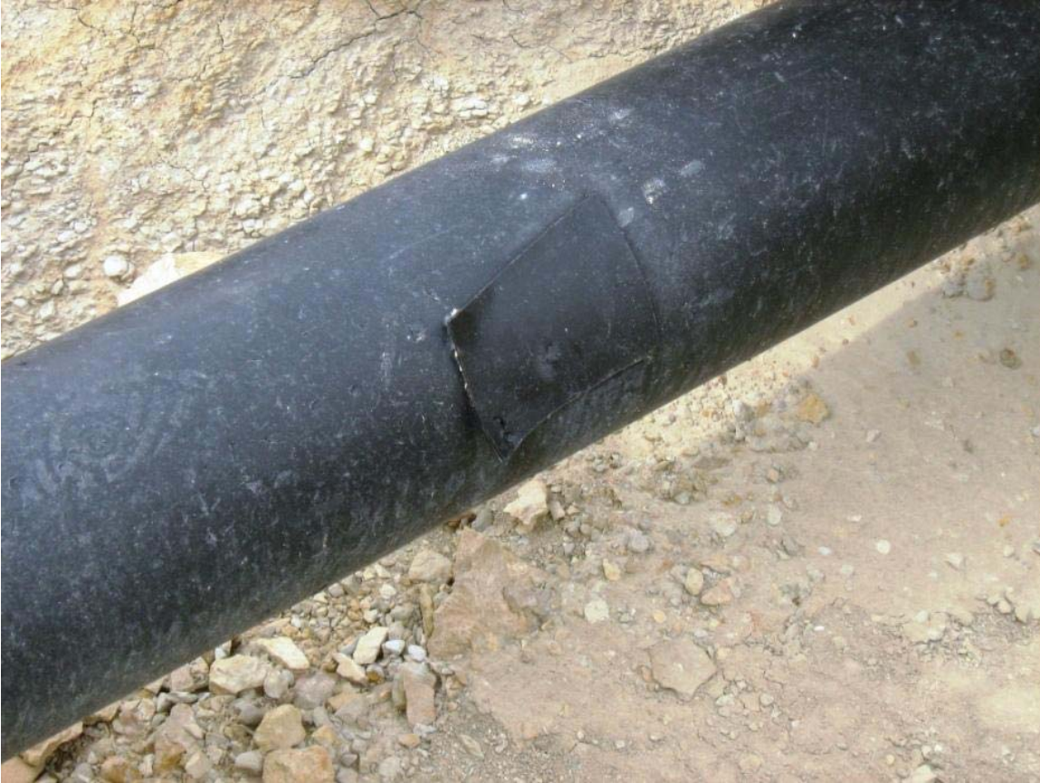
ترمیم پوشش پلی اتیلن سه لایه
