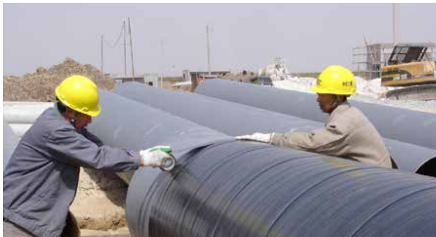
شکل ۱۶: پوشش با نوار پلی اتیلن
