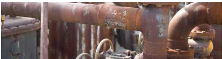
شکل ۱: خوردگی لوله و اتصالات در پالایشگاه نفت (پالایشگاه ریچموند شرکت شورون)
