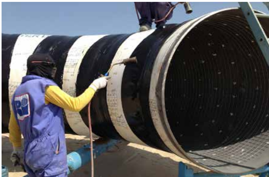
شکل ۱۵: پوشش با نوار انقباضی حرارتی
