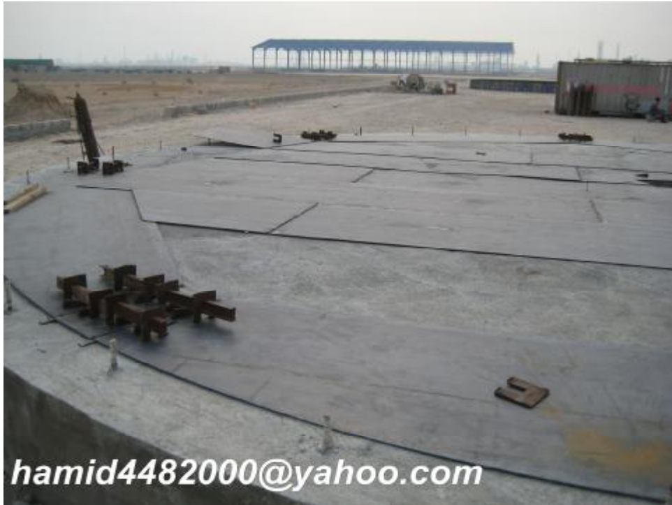
شکل 23 -جانمایی ورقهای Bottom plate
