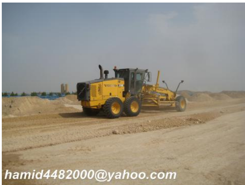
شکل 6- تسطیح لایه های مخلوط زیر مخازن
