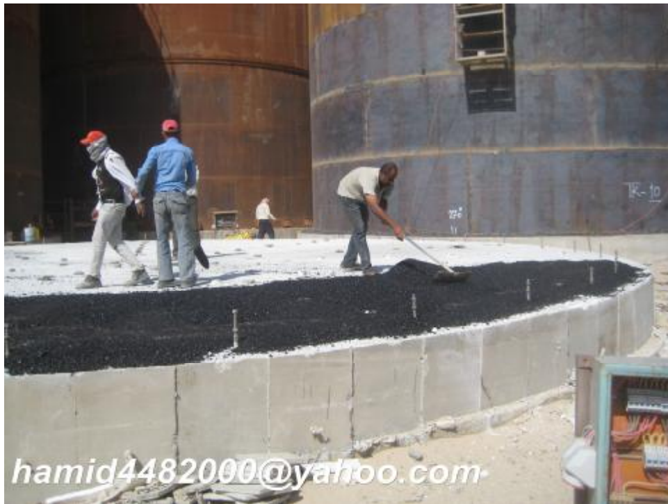
شکل 19- اجرای آسفالت روی فونداسیون مخازن
