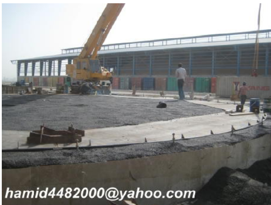
شکل 22- جوشکاری ورقهای Anuular plate
