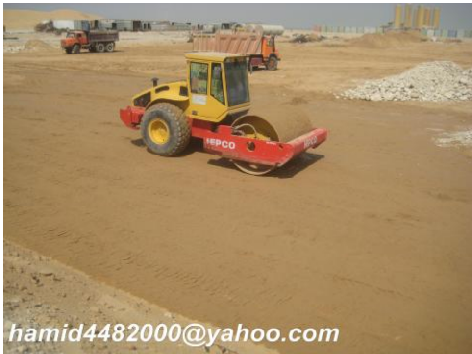
شکل 4 - کوبش ماسه بادی زیر مخازن تا رسیدن به تراکم لازم
