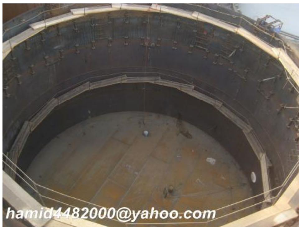
شکل 31- نصب تخته داربست در کورس های بالاتر
