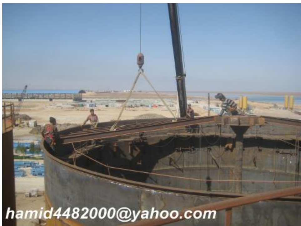
شکل 52 - نصب دو عدد تیر اول سقف بر روی بدنه و ستون میانی
