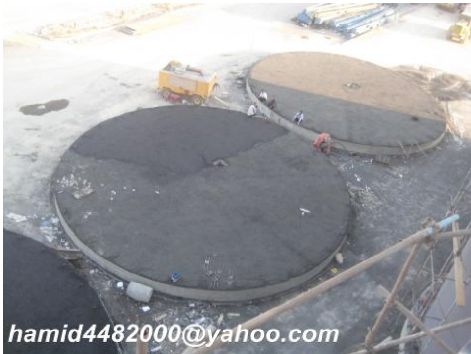
شکل 20- آسفالت زیر مخازن
