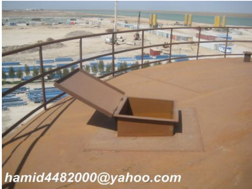
شکل 66 - نصب Roof manhole
