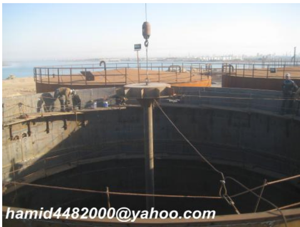
شکل 45 - نصب ستون میانی و مهار کردن آن توسط کابل به بدنه مخزن
