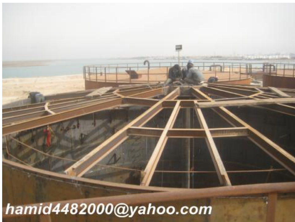
شکل 53 - نصب تیر های سقف بر روی بدنه و ستون میانی
