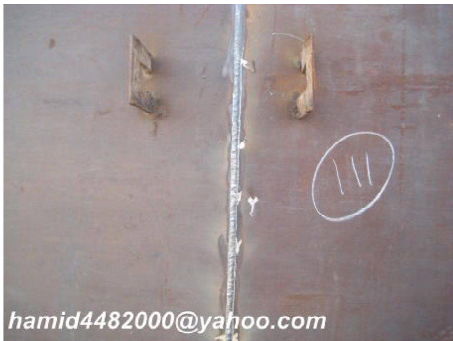
شکل 33 - جوشکاری درزهای عمودی کورس اول
