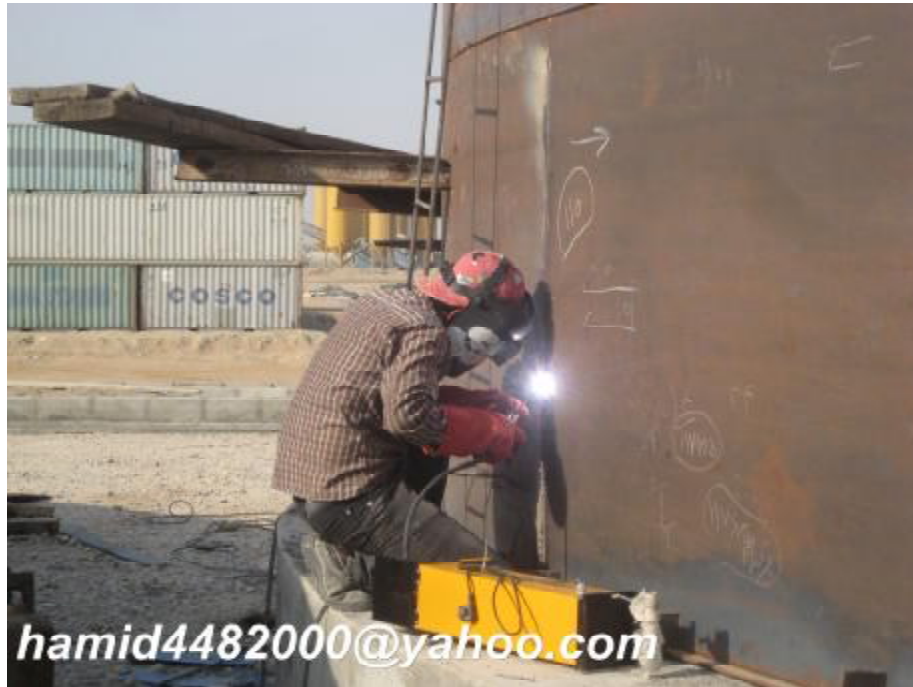
شکل 32 - جوشکاری درزهای عمودی کورس اول
