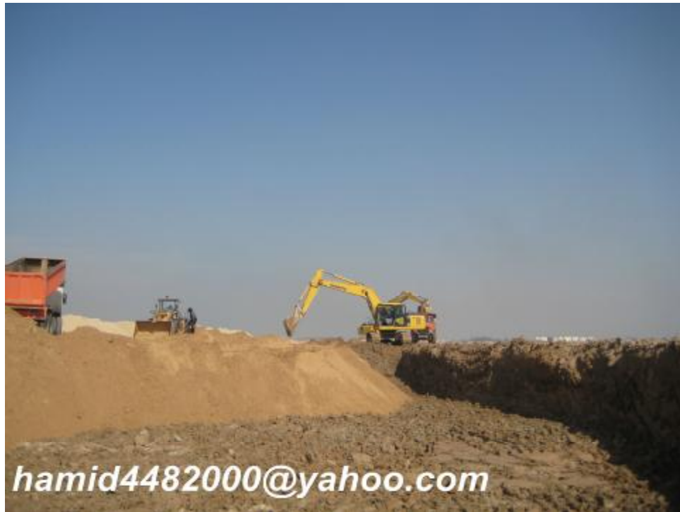
شکل 3 - تخلیه و تسطیح ماسه بادی زیر مخازن
