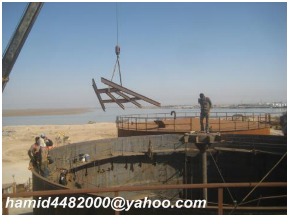
شکل 48 - انتقال دو عدد تیر اول سقف برای نصب توسط جرثقیل
