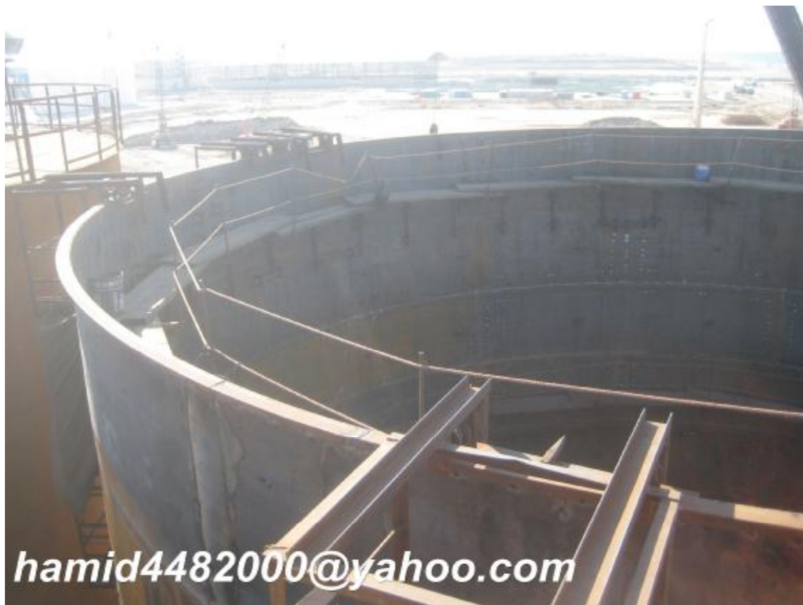
شکل 38 - نصب Top Angle
