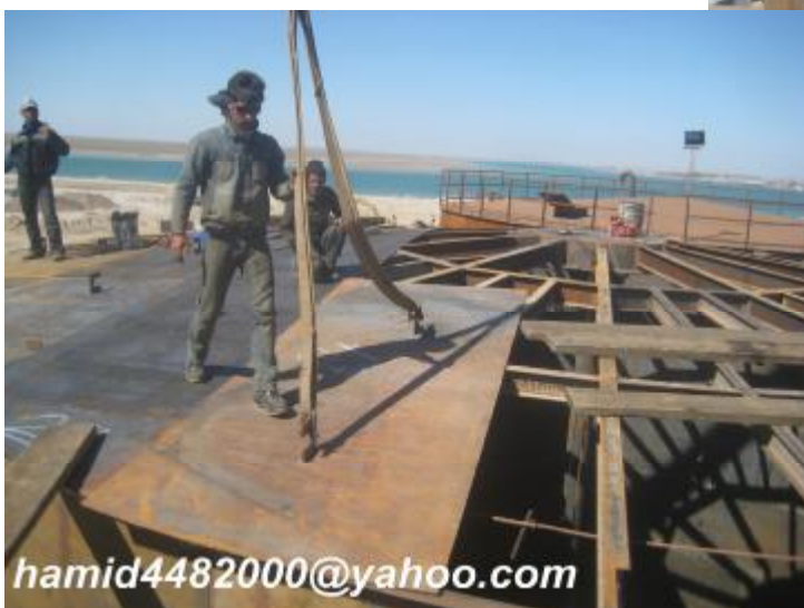
شکل های 57 تا 60 - نصب ورق های Roof Plate
