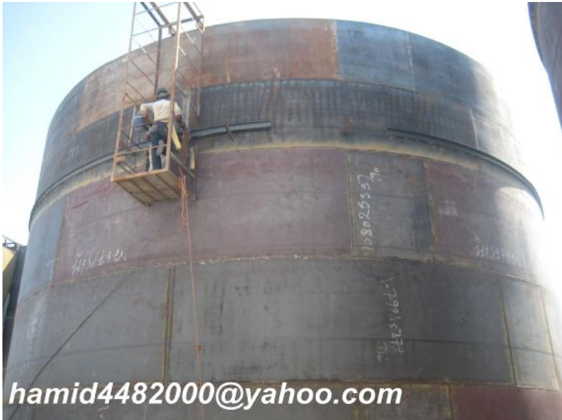
شکل 37 - جوشکاری Wingirder
