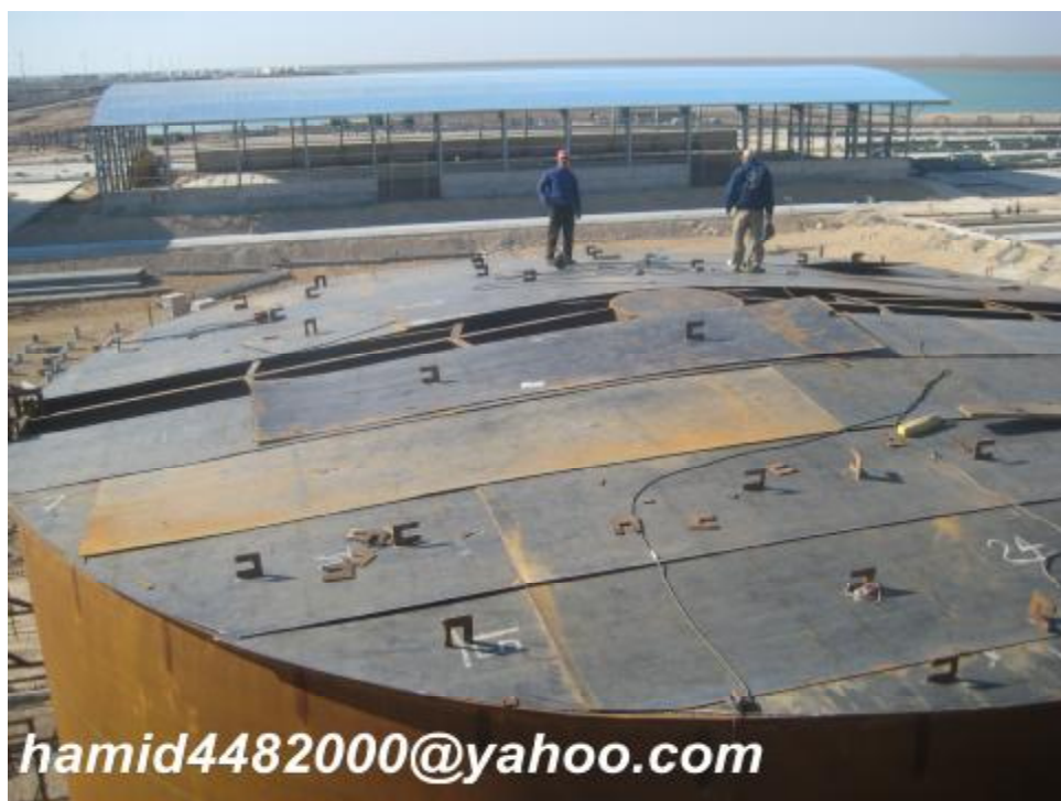
شکل 62 - نصب ورق های Roof Plate
