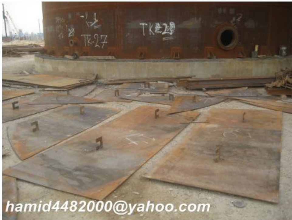
شکل 55 - برشکاری و شماره گذاری ورق های Roof Plate
