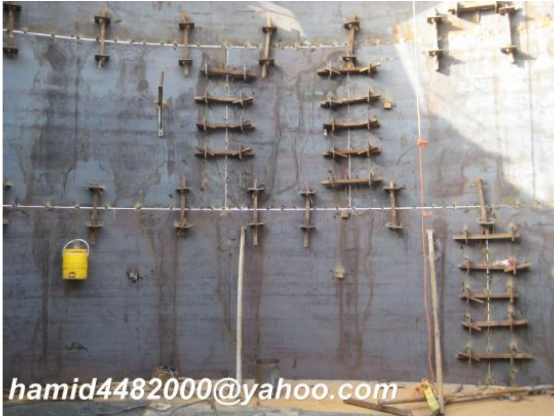
شکل 34 - رعایت فاصله (Gap) بین ورقها
