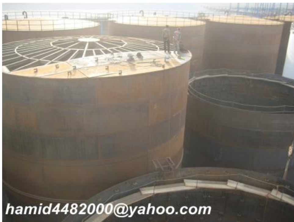
شکل 61 - نصب ورق های Roof Plate
