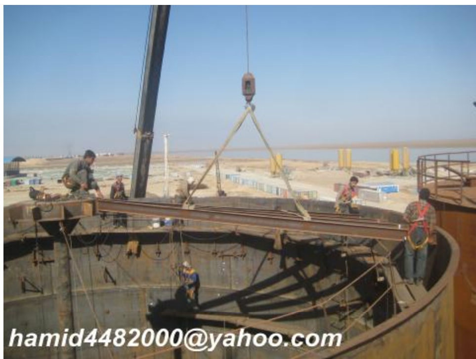
شکل 49 - نصب دو عدد تیر اول سقف بر روی بدنه و ستون میانی
