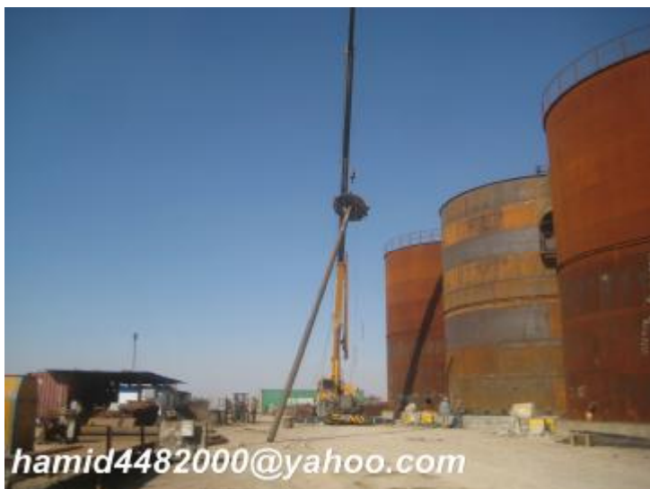
شکل 44 - مراحل نصب ستون میانی
