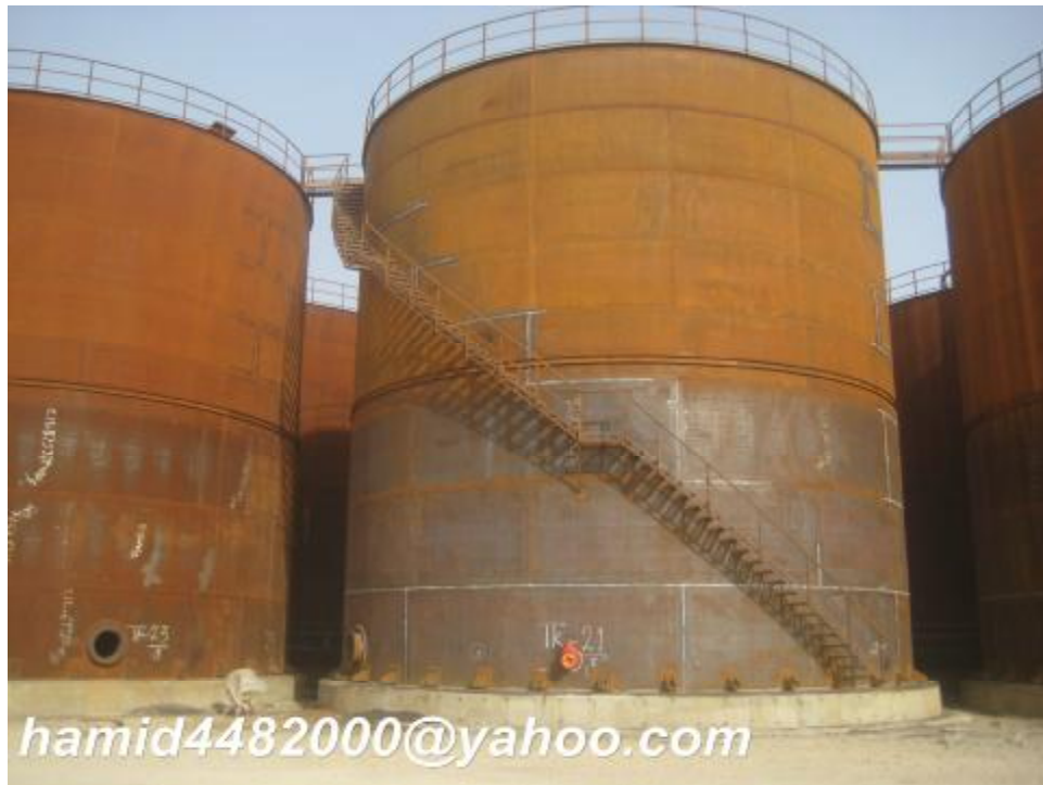
شکل 68 - نصب راه پله مخازن
