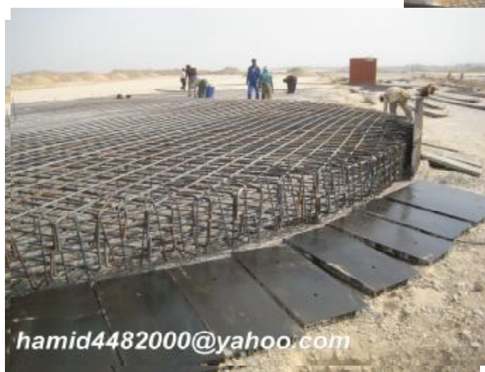
شکل 10 تا 13 - عملیات آرماتوربندی فونداسیون مخازن
