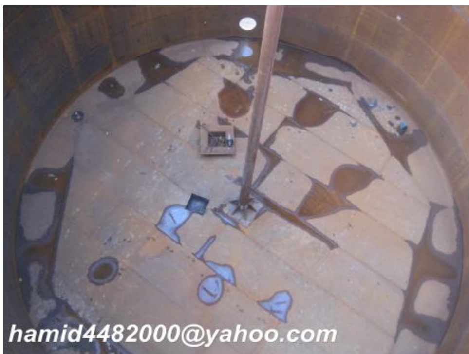
شکل 46 - نصب ستون میانی در محل گلدانی کف مخزن
