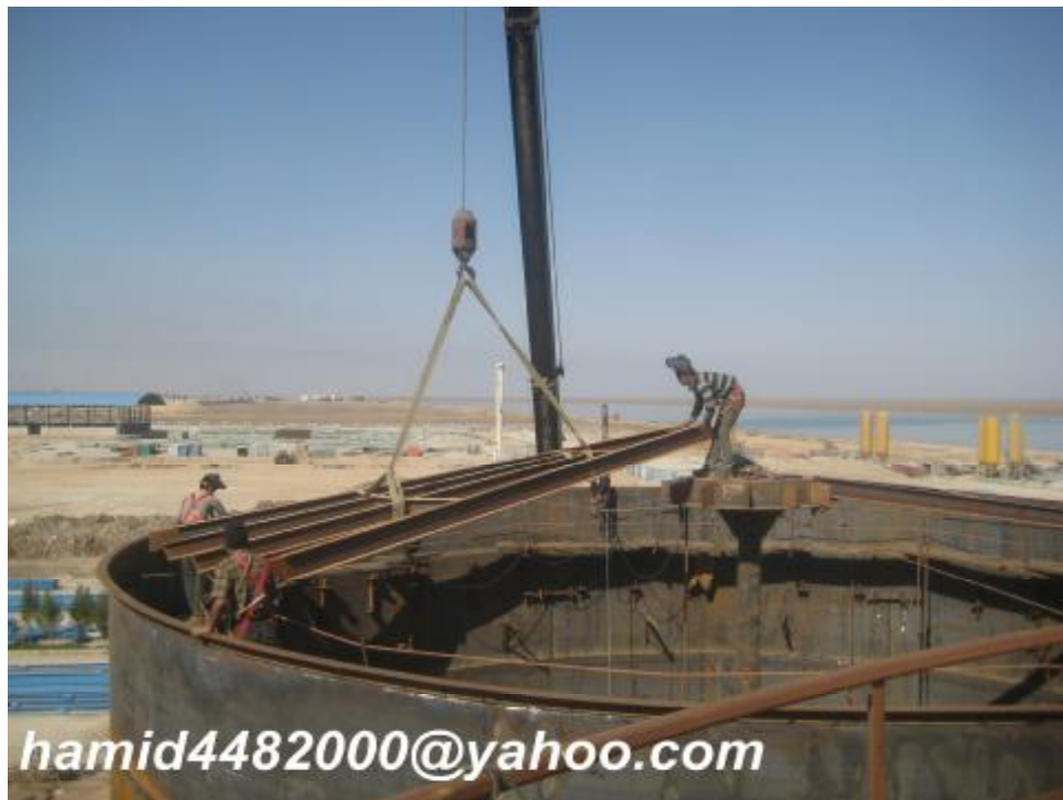
شکل 51 - انتقال دو عدد تیر دوم سقف برای نصب توسط جرثقیل
