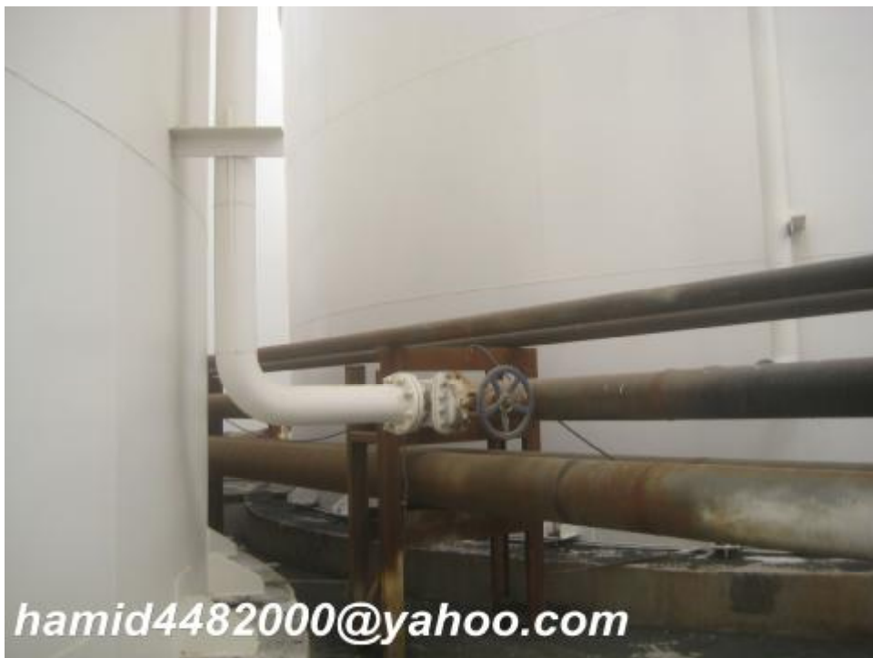
شکل 71 - نصب Inlet Nozzle به سیستم Piping
