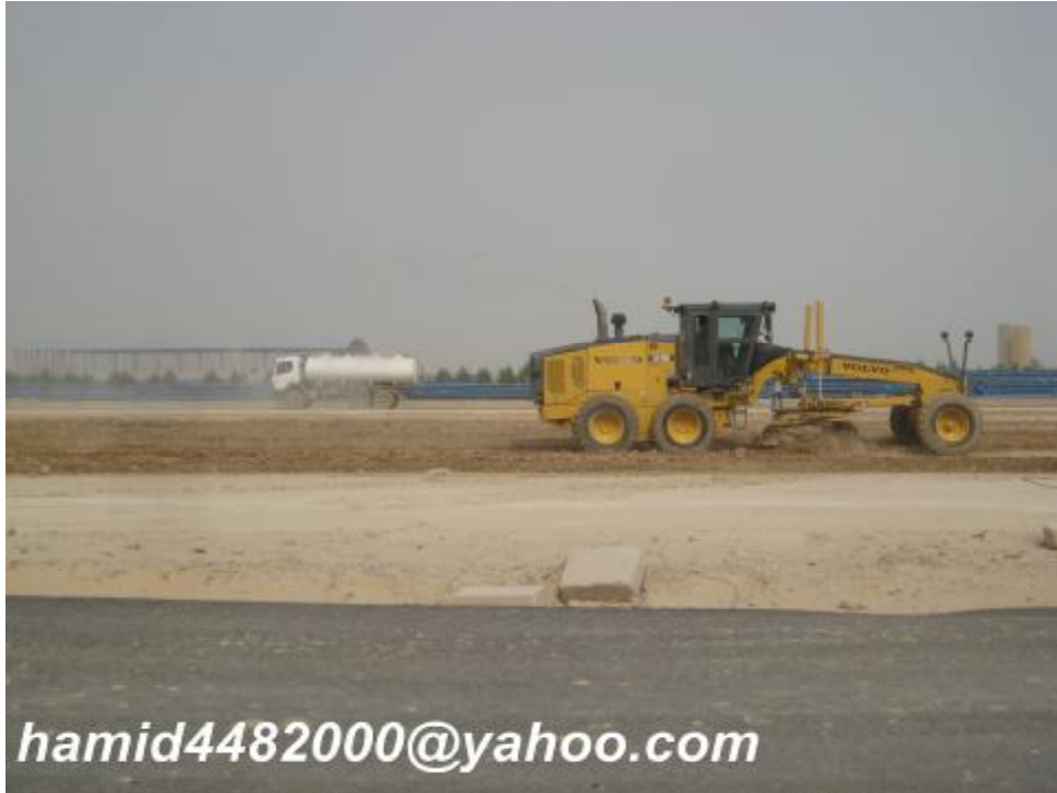
شکل 7- تسطیح لایه های مخلوط زیر مخازن
