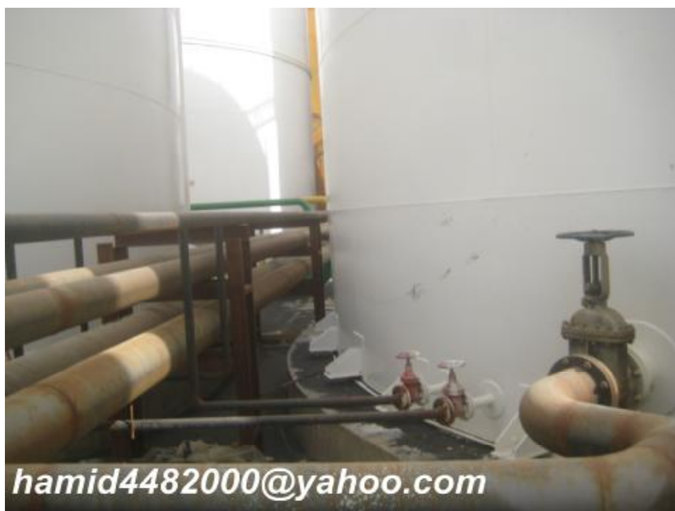
شکل 73 - نصب Outlet Nozzle به سیستم Piping
