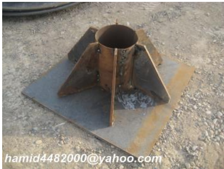
شکل 43 - ساخت گلدانی محل قرارگیری ستون میانی
