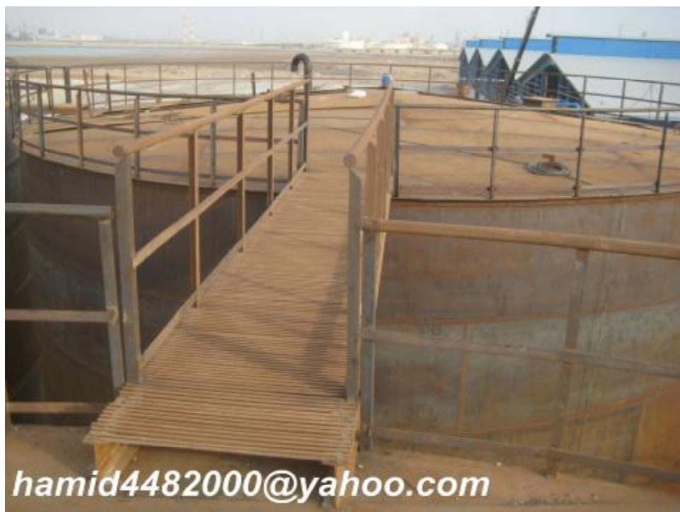
شکل 69 - نصب پل های ارتباطی مخازن
