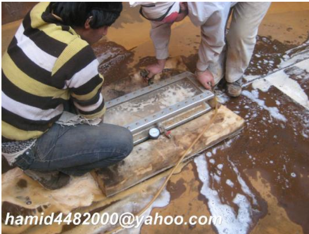
شکل 25 - عملیات تست وکیوم ورق های Bottom plate
