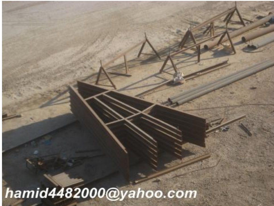
شکل 47 - ساخت تیرهای سقف
