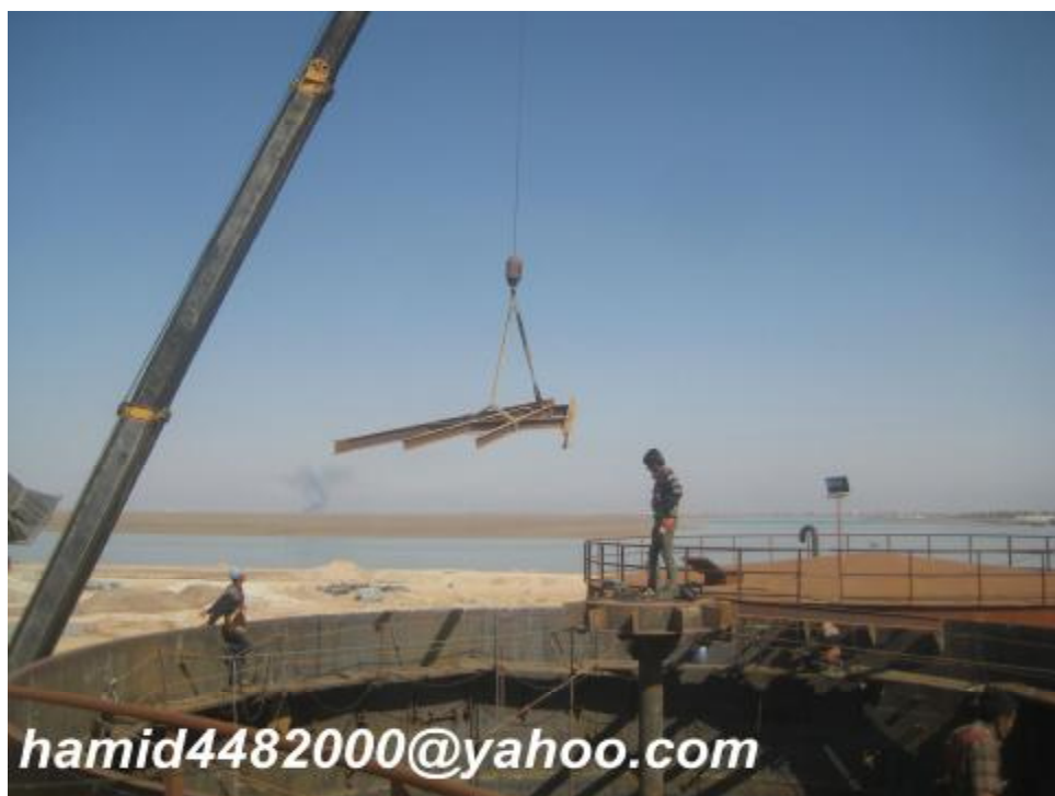
شکل 50 - انتقال دو عدد تیر دوم سقف برای نصب توسط جرثقیل
