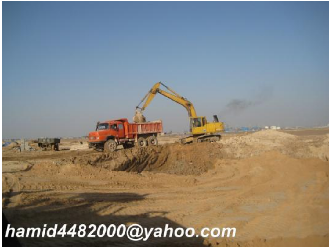
شکل 2 - عملیات خاکبرداری
