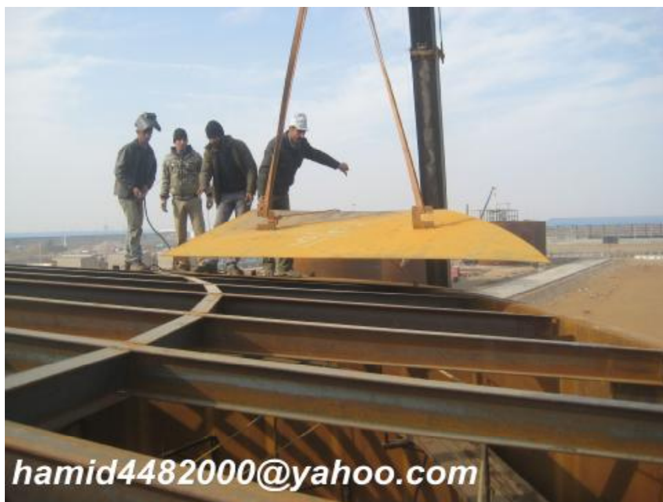
شکل 56 - جانمایی ورق های Roof Plate
