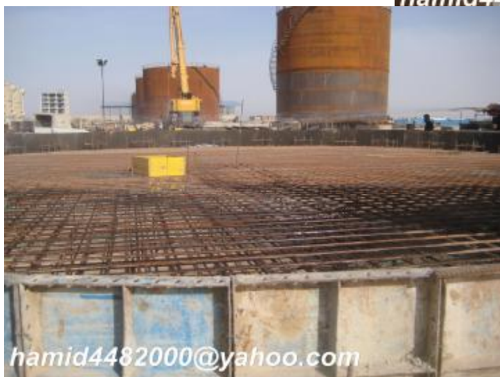
شکل 14 تا 16 - قالب بندی فونداسیون مخازن
