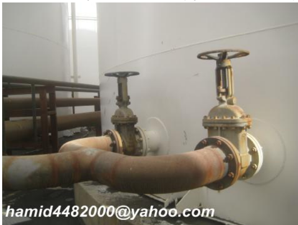
شکل 72 - نصب Outlet Nozzle به بدنه مخزن
