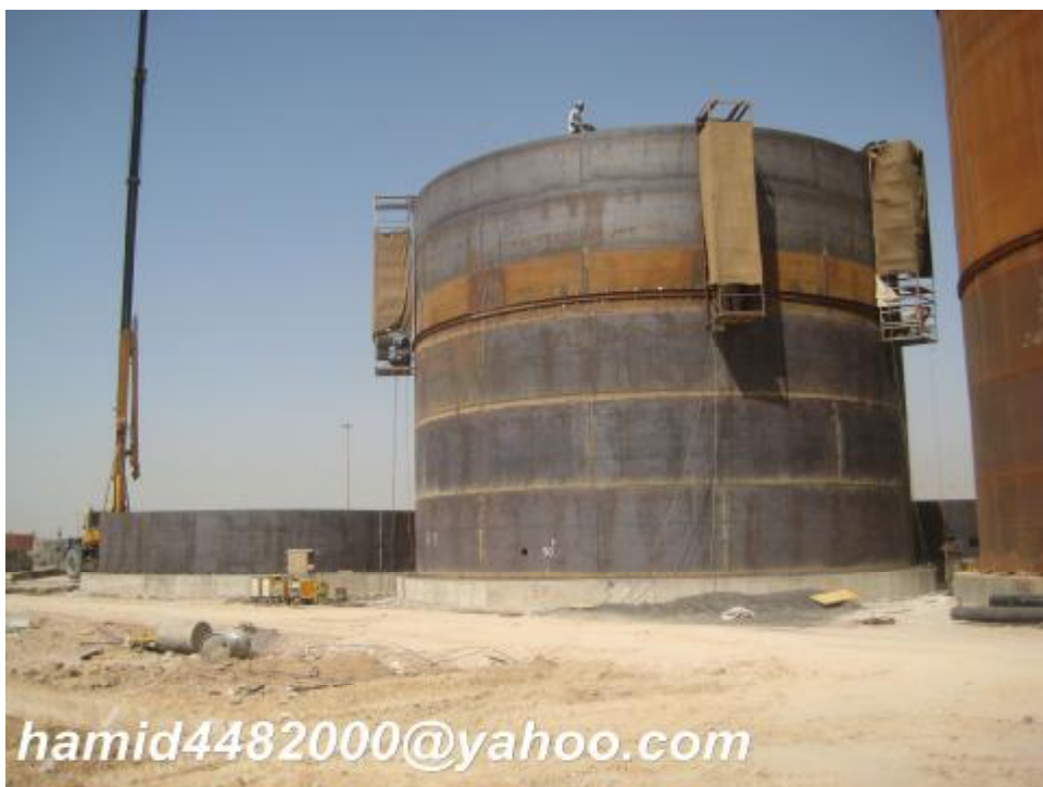
شکل 36 - جوشکاری ورق های shell
