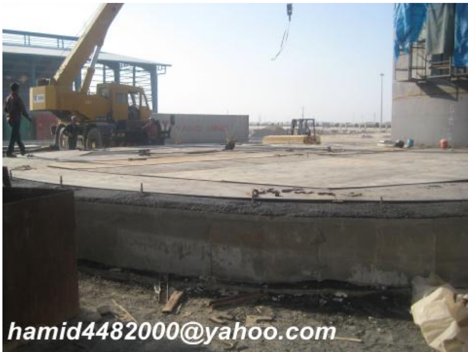
شکل 24 -جوشکاری ورقهای Bottom plate
