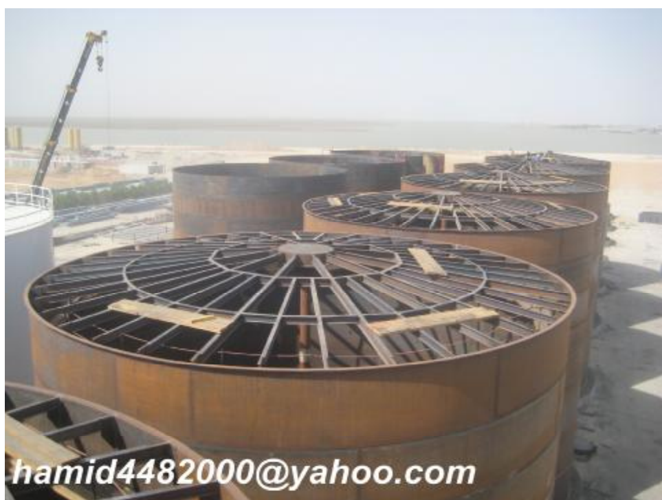
شکل 54 - تیر های نصب شده سقف
