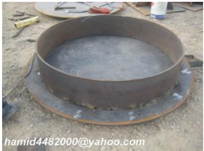
شکل 40 - جوشکاری Central Compression Ring
