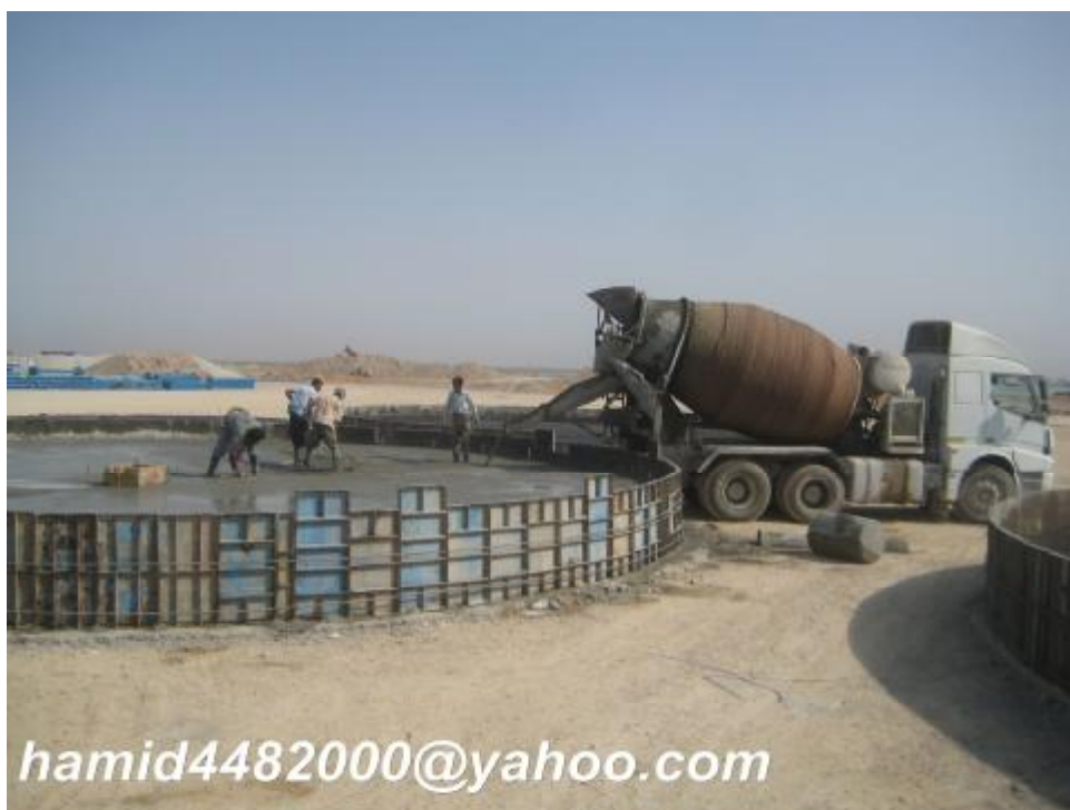
شکل 17 - بتن ریزی فونداسیون مخازن
