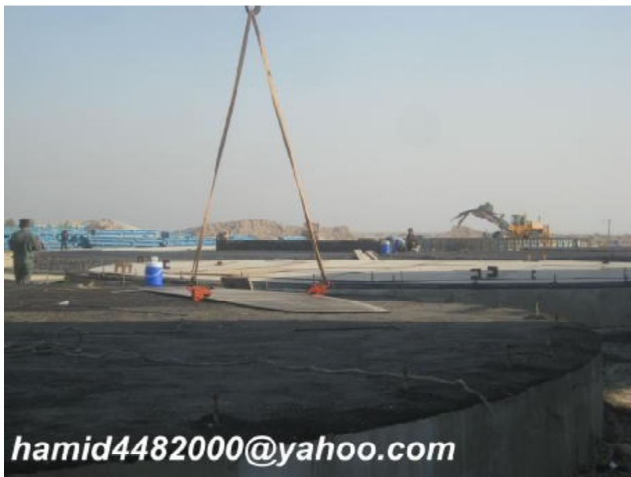
شکل 21- جانمایی ورقهای Anuular plate
