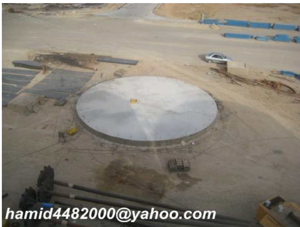
شکل 18 - فونداسیون مخازن بعد از باز کردن قالب
