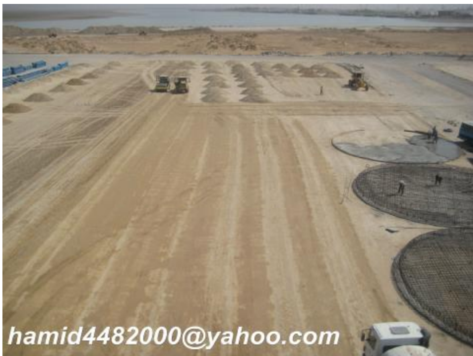
شکل 8- کوبش لایه های مخلوط زیر مخازن
