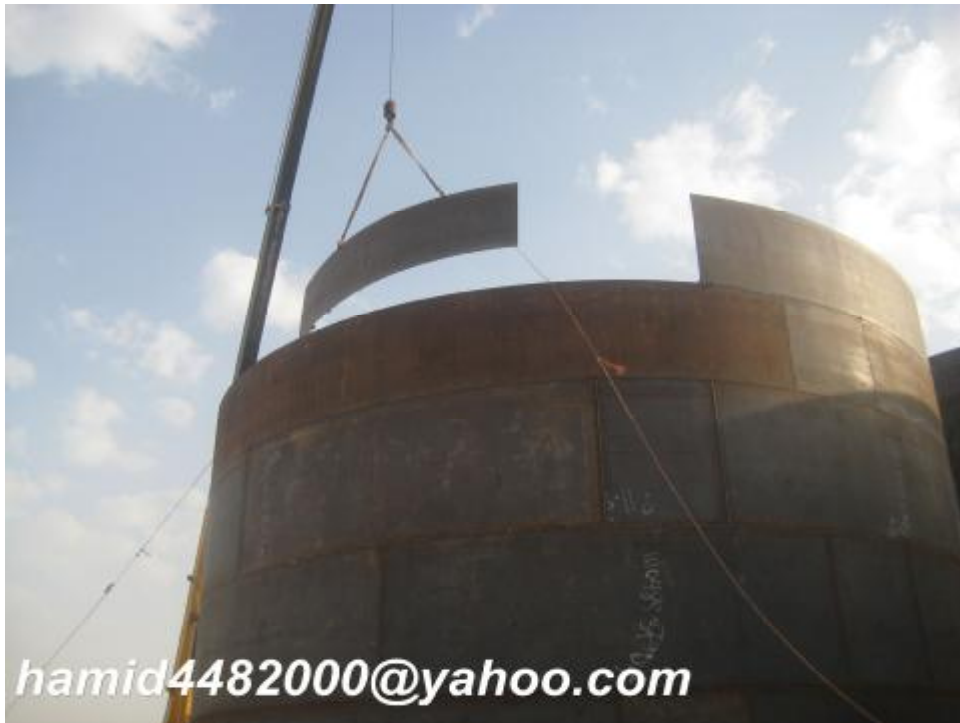
شکل 35 - مونتاژ و نصب ورق های shell
