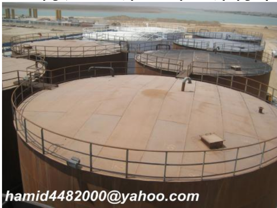
شکل 67 - نصب نرده های محافظ پیرامونی سقف مخازن
