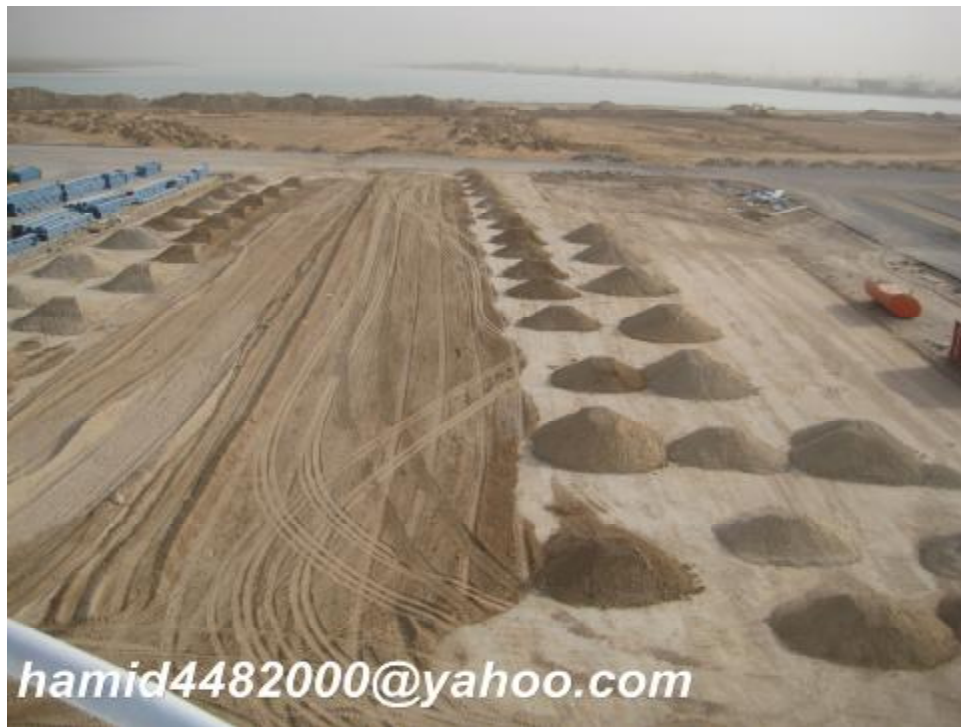
شکل 5 - تخلیه مخلوط زیر مخازن
