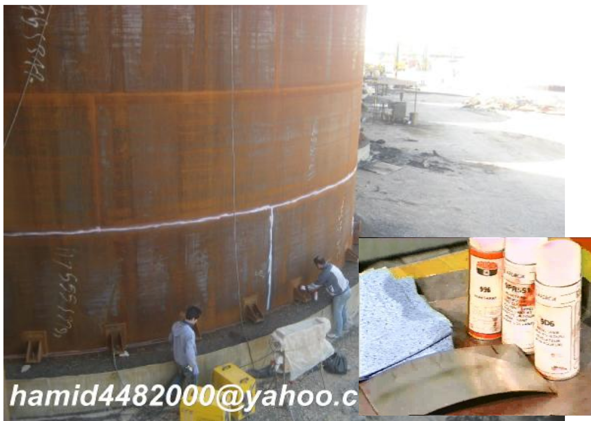
شکل 74 - انجام آزمایش PT
