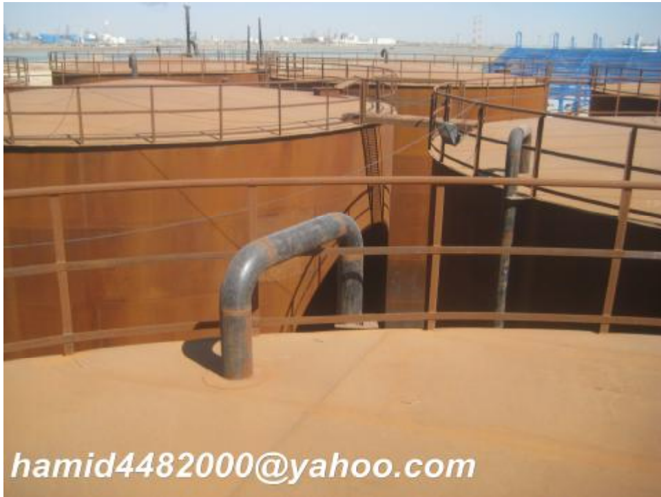
شکل 70 - نصب Inlet Nozzle به سقف مخزن
