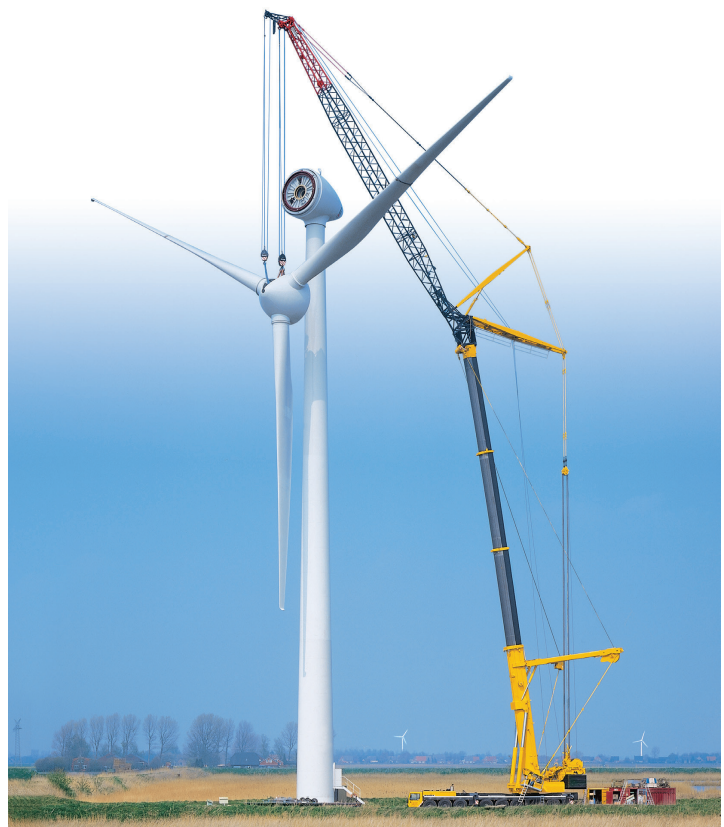
شکل ۱: جرثقیل بسیار بزرگ در حال نصب توربین بادی
