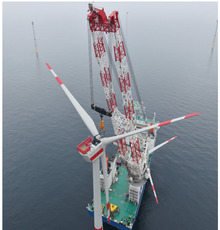
شکل ۵: جرتقیل جک آپ در حال نصب توربین بادی
