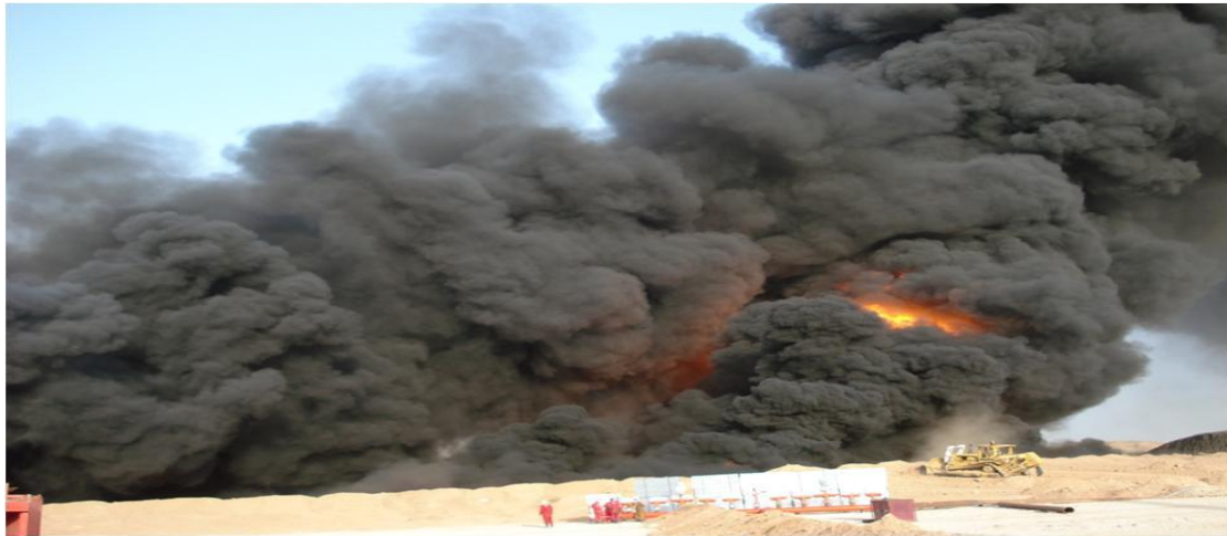
شکل ۷: نمایی از عملیات احداث خاکریز در اطراف شعله های آتش
