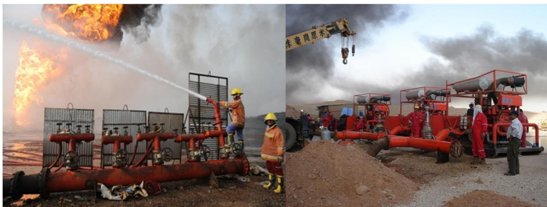
شکل ۹: نمایی از عملیات خنک سازی ادوات و تجهیزات مهار فوران
