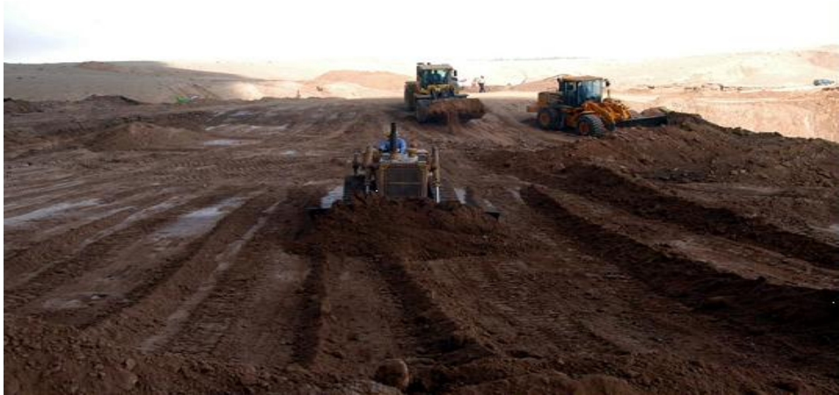
شکل ۵: نمایی از ساخت حوضچه های ذخیره سازی آب
