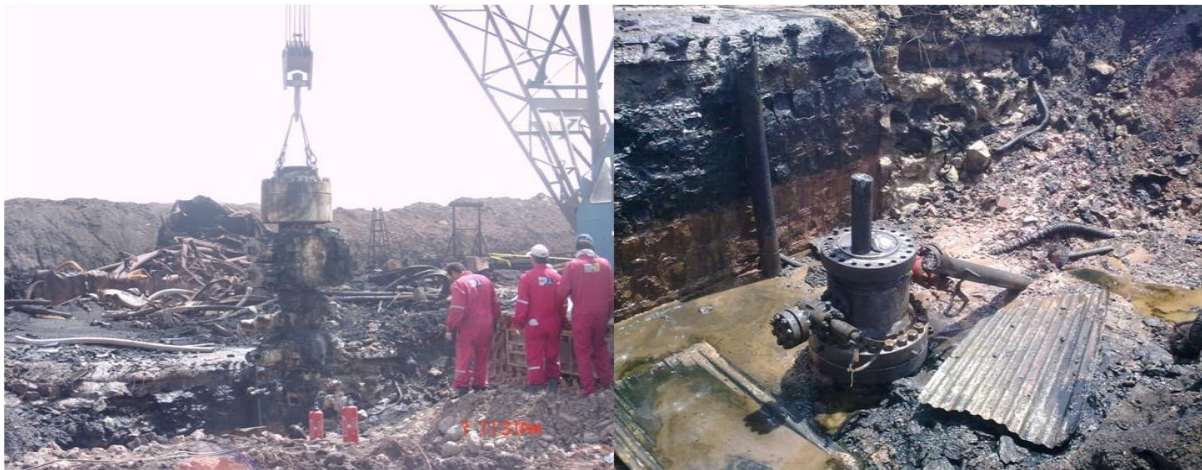
شکل ۱۱: نمایی از عملیات نصب تاج چاه
