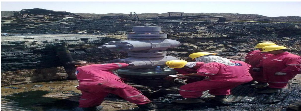
شکل ۱۲: نمایی از مراحل پایانی نصب تاج چاه جهت متروکه سازی آن
