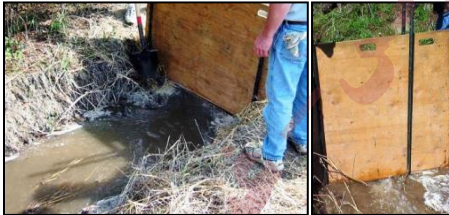
شکل پ. ۴-۶- ایجاد مانع برای گسترش آلودگی با کمک آب‌بندهای موقت و خاشاک منطقه
