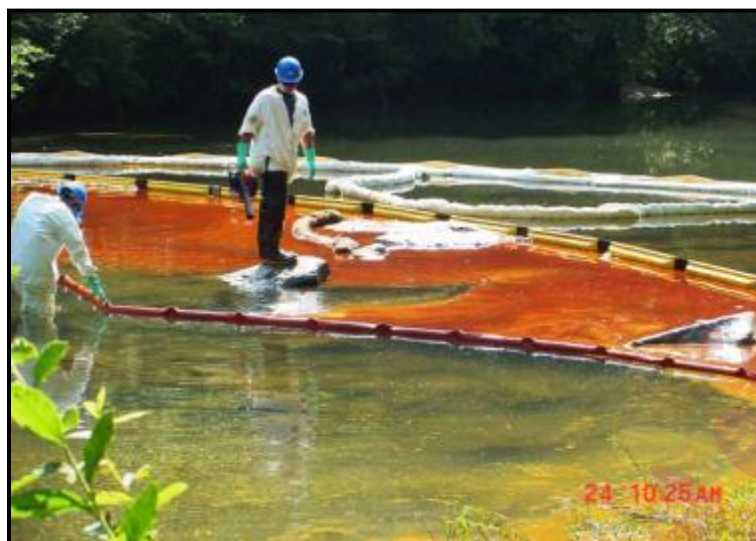
شکل پ.۴-۱۷- محدود سازی و جمع‌آوری لکه‌های نفتی با کمک بوم‌ها در یک منطقه خاص از رودخانه
