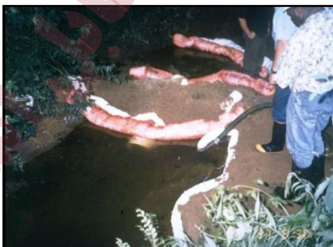
شکل پ.۴-۲۵- نمونه‌ای از بوم‌های جذب‌کننده نفت
