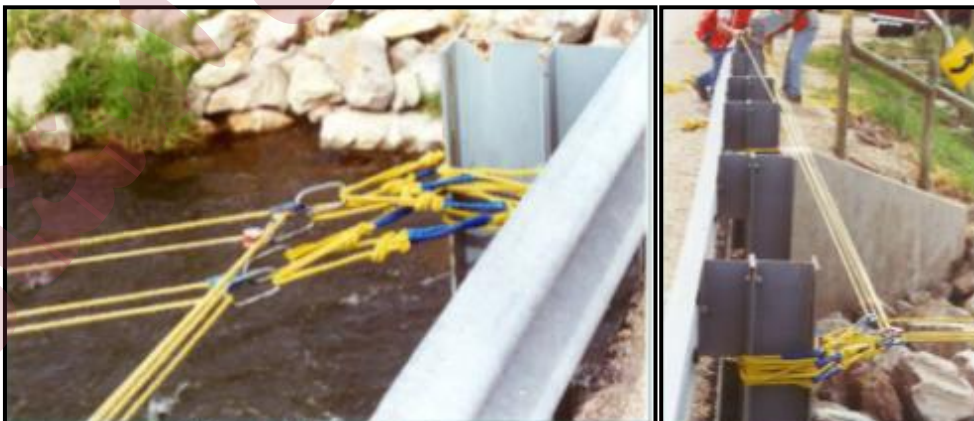
شکل پ.۴-۴۶- انواع تکیه‌گاه‌ها در بوم‌گذاری (ساحل به پل)
