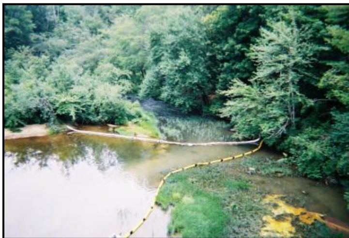
شکل پ.۴-۱۴- استفاده از بوم‌ها برای محافظت از مناطق حساس (مانند با پوشش گیاهی یا مناطق زیست حیوانات)
