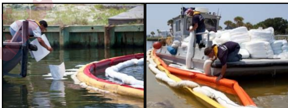
شکل پ.۴-۵۸- کاربرد بوم‌های مهار، بوم‌های جاذب و ورقه‌های جاذب نفت در کنار هم
