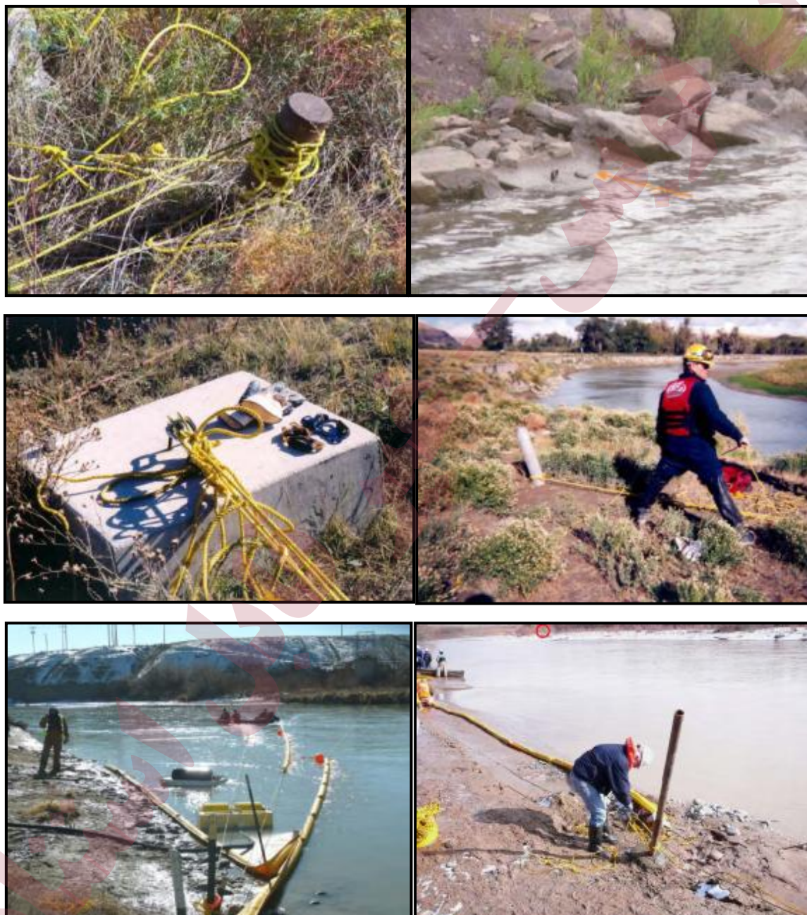
شکل پ. ۴-۴۷- نصب تکیه‌گاه‌های دائمی در کنار رودخانه‌ها به منظور افزایش سرعت بوم‌گذاری در حین مقابله
