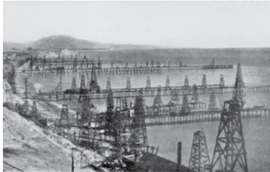
شکل ۱: اسکله های نصب شده در ساحل سامرلند برای حفاری در دریا
