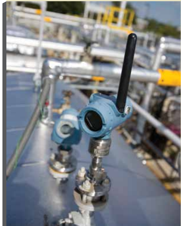
شکل ۱: جریان سنج با فرستنده بی سیم
