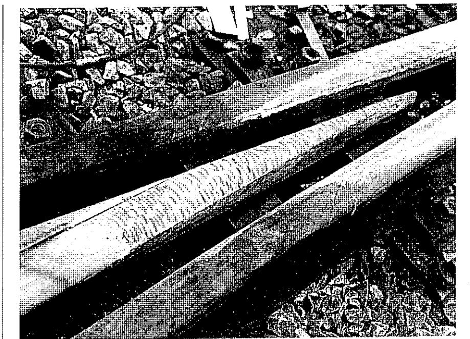
شکل [۷] ب) تکه مرکزی پس از جوشکاری و قبل از سنگزنی
