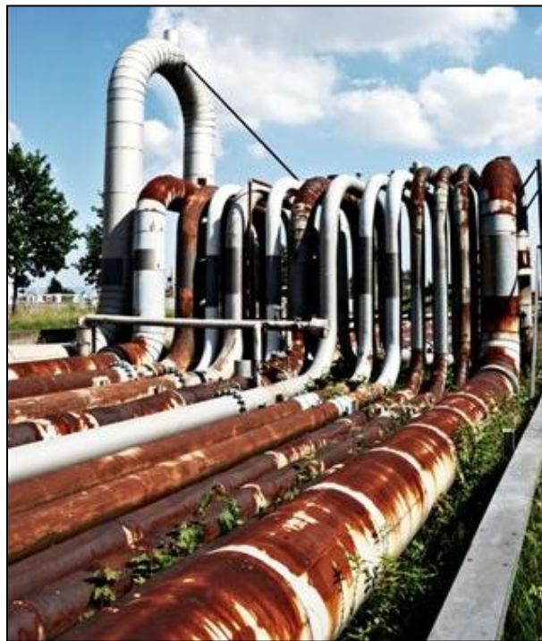
شکل (۳) خوردگی در تاسیسات پالایشگاهی [۷]
