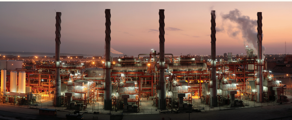
شکل ۷: نمایی از تجهیزات تامین شده در فازهای ۱۵ و ۱۶ پارس جنوبی
