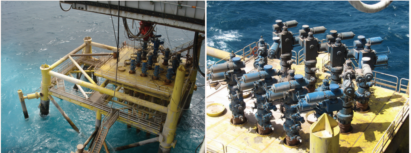
شکل ۱۱: نمایی از شیرآلات سرچاهی قبل (سمت چپ) و بعد (سمت راست) از تکمیل چاه‌های فاز ۱۶
