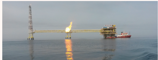
شکل ۱۴: عملیات اسیدکاری Rigless
