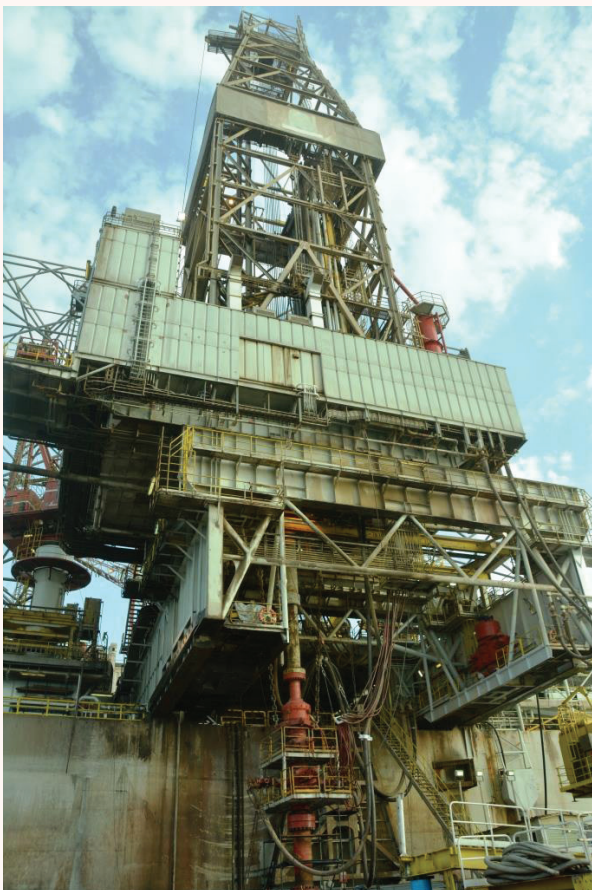
شکل ۹: نمایی از جک آپ ریگ هنگام عملیات حفاری
