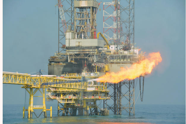
شکل ۱۳: عملیات سه‌گانه حفاری، تولید و انگیزش در فاز ۱۵، (TRIOPS)
