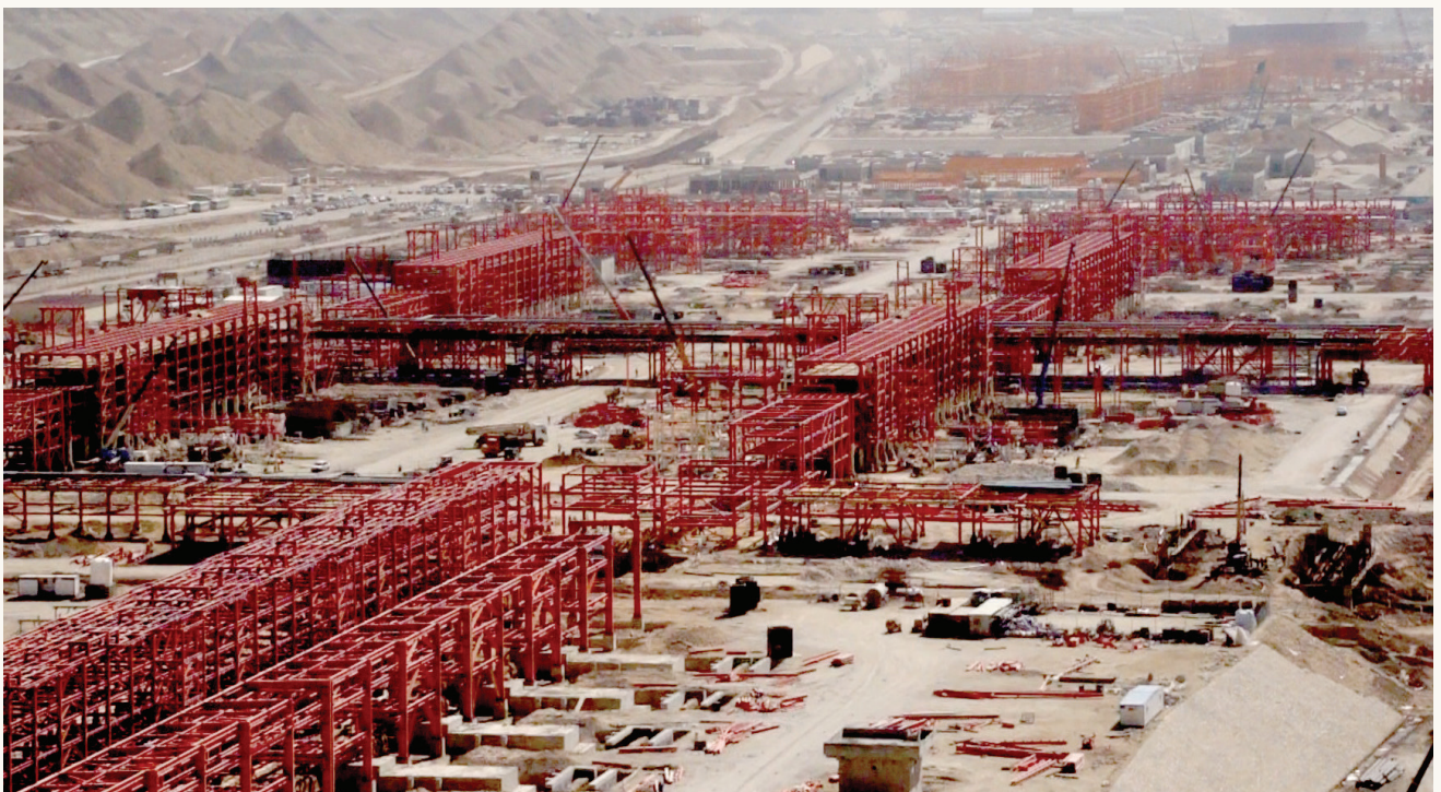
شکل ۵: نصب استراکچر در پالایشگاه فازهای ۱۵ و ۱۶
