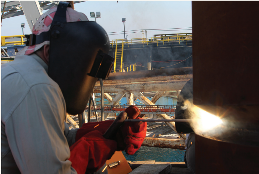
شکل ۷: جوشکاری پاپینگ در پالایشگاه فازهای ۱۵ و ۱۶
