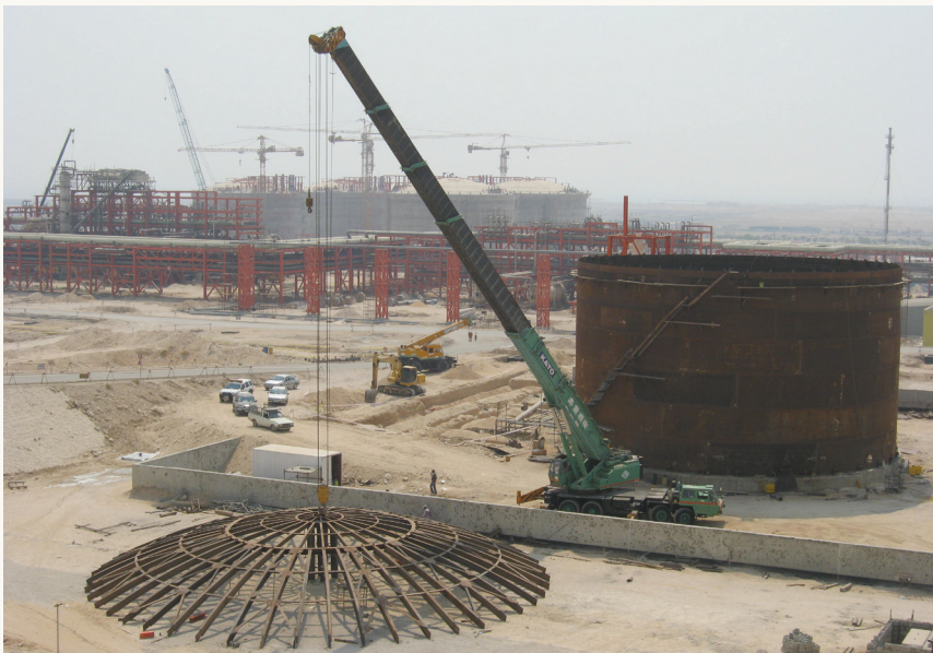
شکل ۳: نصب سقف یکی از مخازن پالایشگاه فازهای ۱۵ و ۱۶
