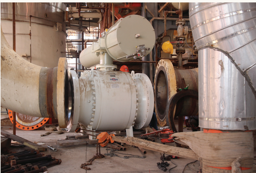
شکل ۹: نصب تجهیزات (شیر قابل کنترل) در پالایشگاه فازهای ۱۵ و ۱۶
