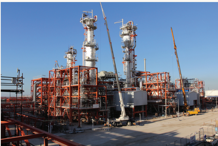
شکل ۴: نصب تجهیزات در پالایشگاه فازهای ۱۵ و ۱۶
