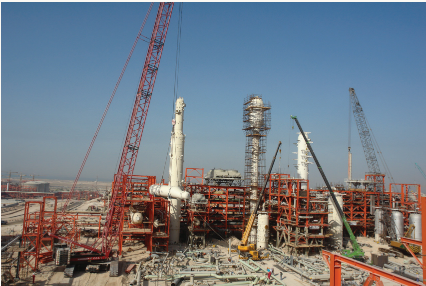
شکل ۸: نصب یک مبدل حرارتی در پالایشگاه فازهای ۱۵ و ۱۶
