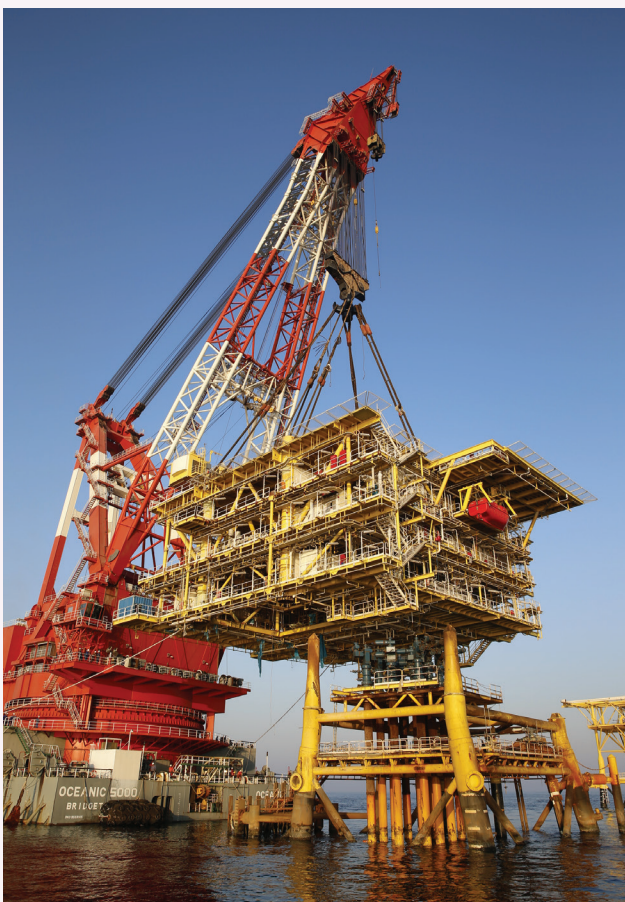
شکل ۲: عملیات نصب سکو فاز ۱۶ مگا پروژه فازهای ۱۵ و ۱۶ با وزن بیش از ۲۷۰۰ تن و ارتفاع ۲۳ متر
