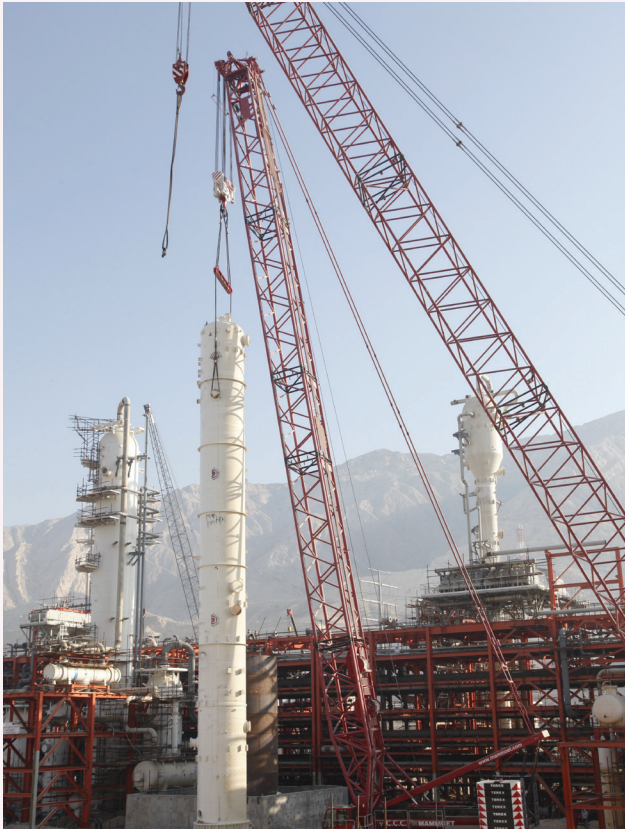
شکل ۱: عملیات نصب یکی از برج‌های بزرگ مگا پروژه فازهای ۱۵ و ۱۶
