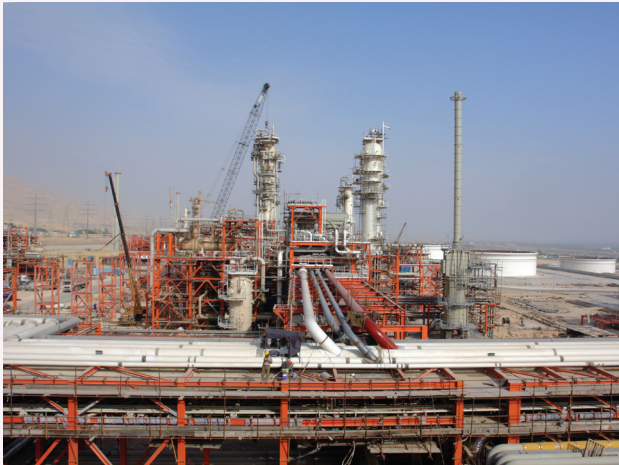
شکل ۳: نمایی از عملیات نصب تجهیزات در پالایشگاه فازهای ۱۵ و ۱۶
