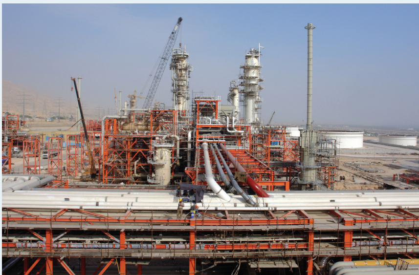
شکل ۱: نصب تجهیزات فرایندی
