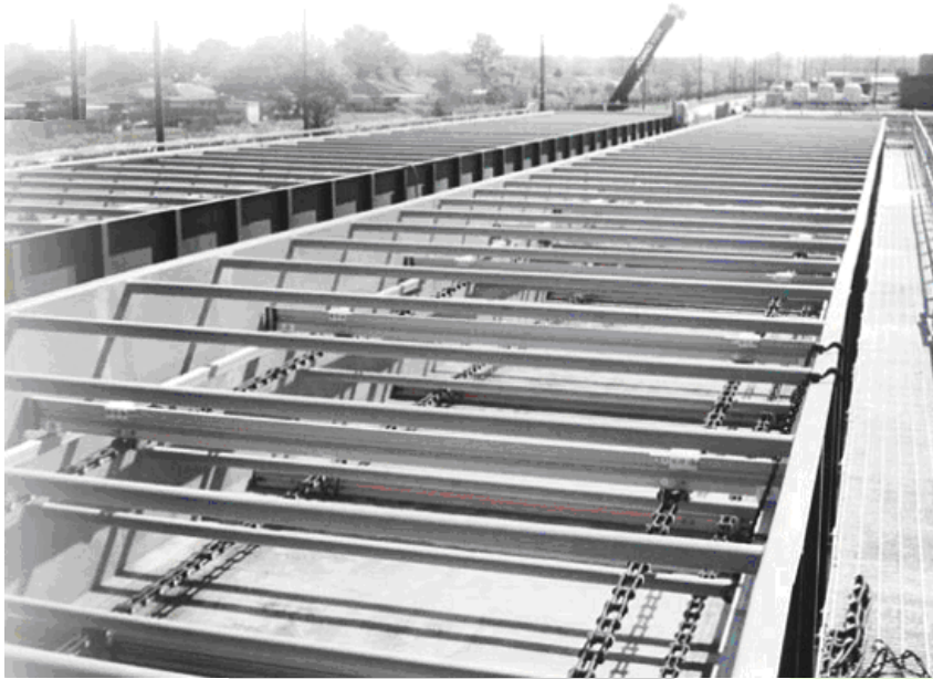
شکل ۲. نمونه ای از یک جداکننده API [۳]
