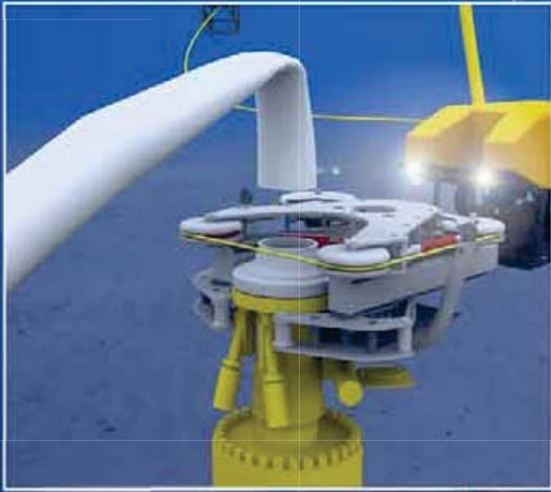
شکل ۲: برش لوله کف دریا بوسیله کاتر الماس با هدایت ROV
