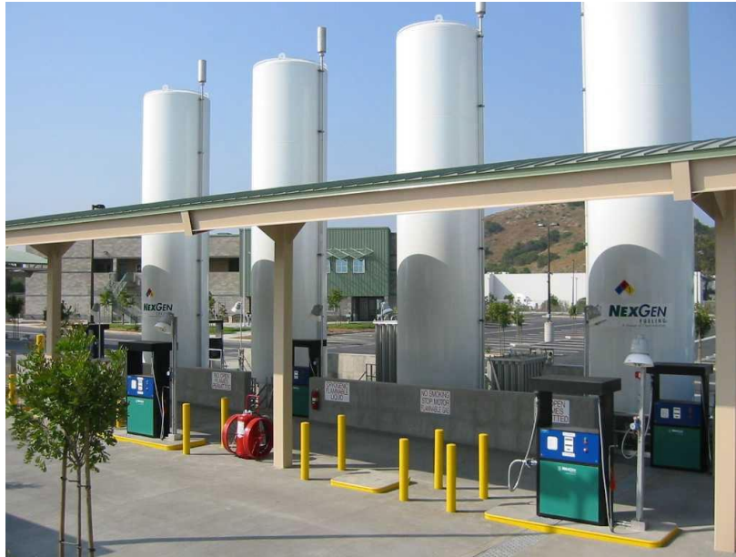
شکل ۱- نمایی از جایگاه سوختگیری LNG همراه با دیسپنسر سوختگیری LCNG
