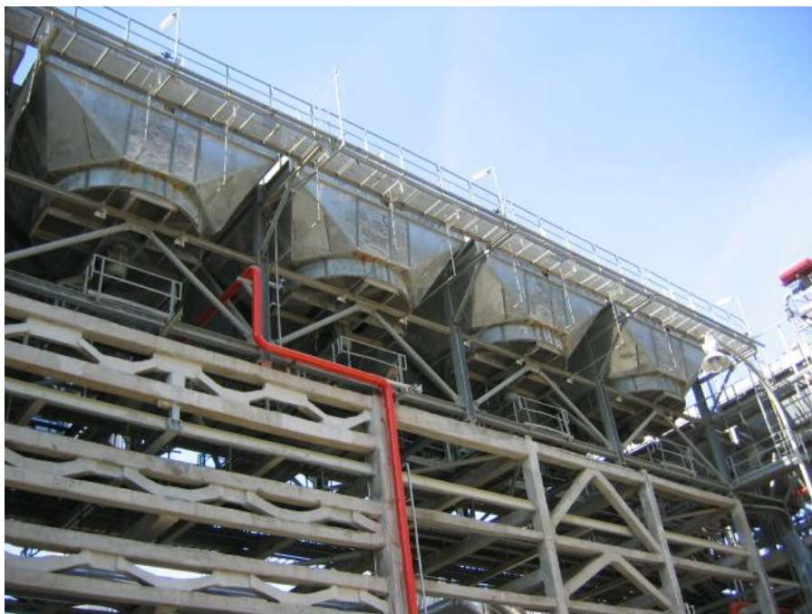
شکل (۴-۵): نمایی از کولرهای هوایی با جابجایی اجباری
