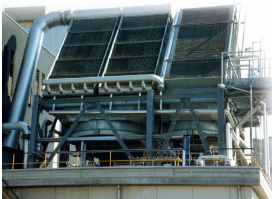
شکل (۴-۷): نمایی از کولرهای هوایی با آرایش دسته لوله های مایل
