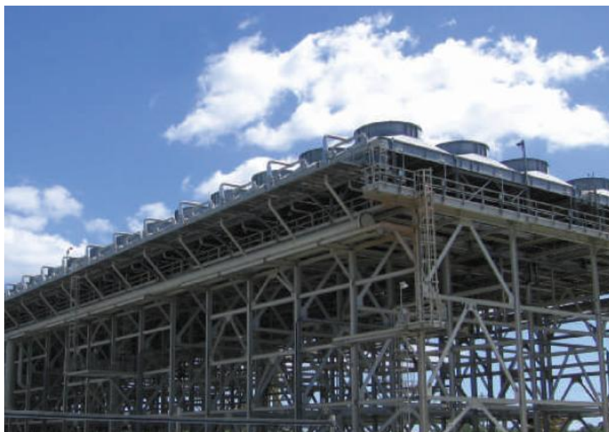
شکل (۴-۴): نمایی از کولرهای هوایی با جابجایی القایی
