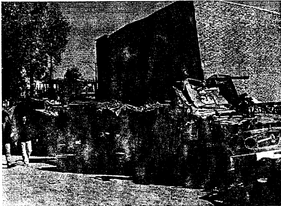
شکل ۲- تخریب ماشین های آتش نشانی در اثر فرو ریزش سازه نگهدارنده در زلزله بم
