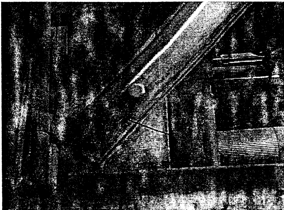
شکل ۲۴- عدم وجود پیچ در المان های سازه ای
