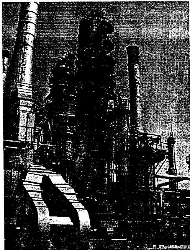
شکل ۱۲- عدم مهار تجهیزات مرتفع و احتمال واژگونی در اثر زلزله و ضربه به تجهیزات مجاور
